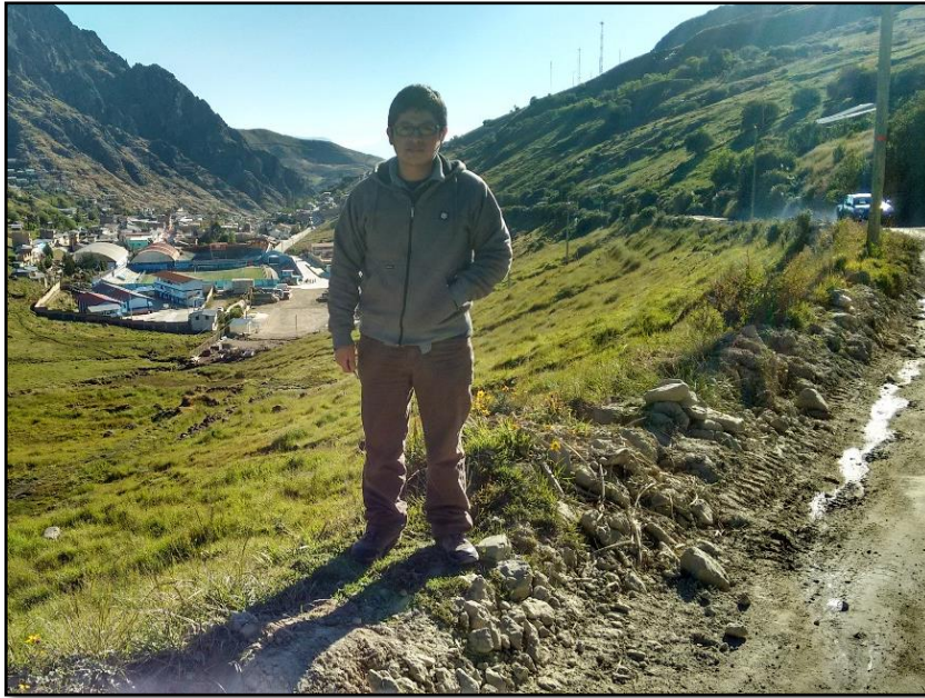
Fotografía N° 9: Vista panorámica de la provincia de Hualgayoc, Km 85+180, tramo que no ha sido asfaltado, con alteración de la calidad del aire por el polvo y erosión.
