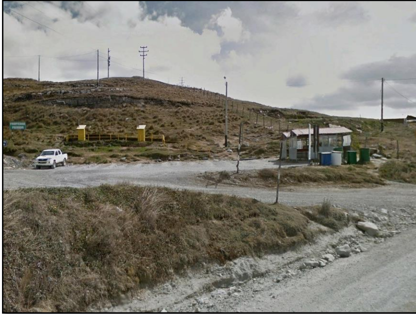
Fotografía N° 7: Zona de parqueo del proyecto Cerro Corona en el Km 80+535, tramo sin asfaltar, alteración del paisaje, generación de ruido y calidad del aire.
