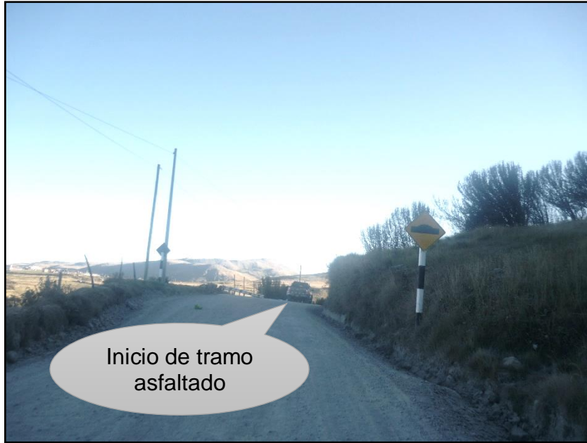
Fotografía N° 1: Punto de inicio del tramo en estudio en el km 64+500 e inicio de tramo asfaltado.
