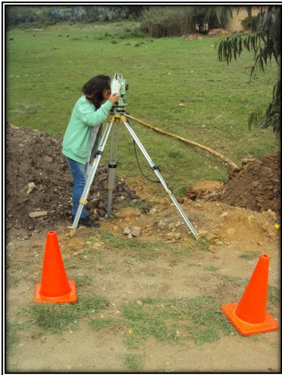
Fotografía N° 06: Toma de puntos con la Estación Total
