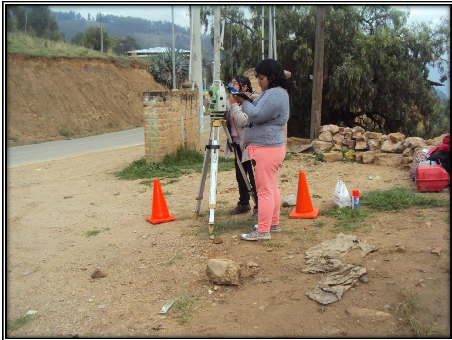
Fotografía N° 08: Ejecución del levantamiento topográfico
