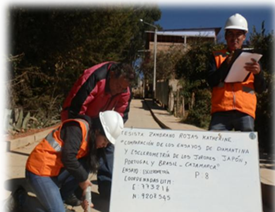
Imagen N° 13: Ensayo de Esclerometría P-8, realizado en la cuadra 1 del Jr. Japón.
