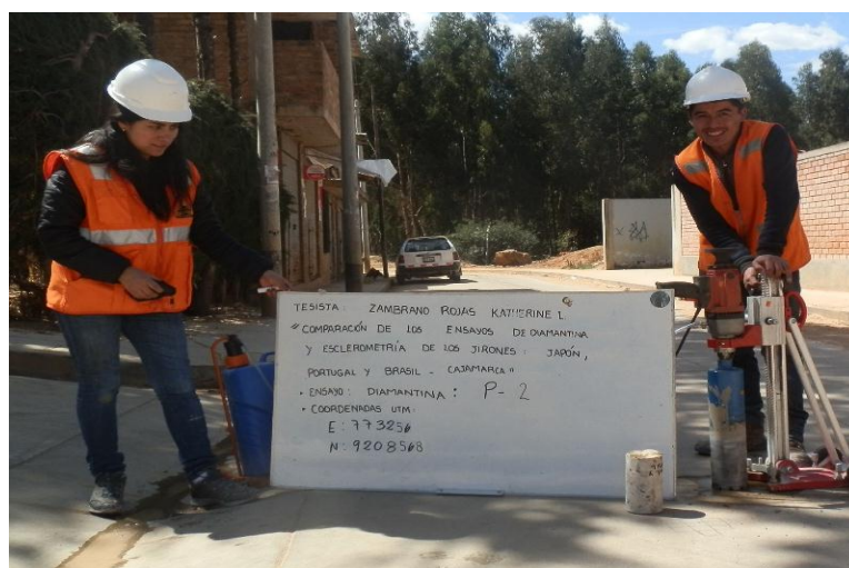
Imagen N° 20: Extracción del espécimen de Concreto P-2 - Intersección del Jr. Portugal y Brasil
