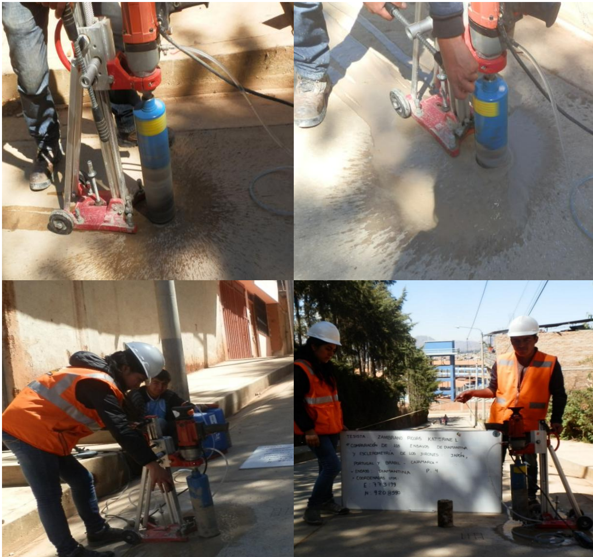
Imagen N° 21: Extracción del Espécimen de Concreto P-4 - Cuadra 1 del Jr. Brasil
