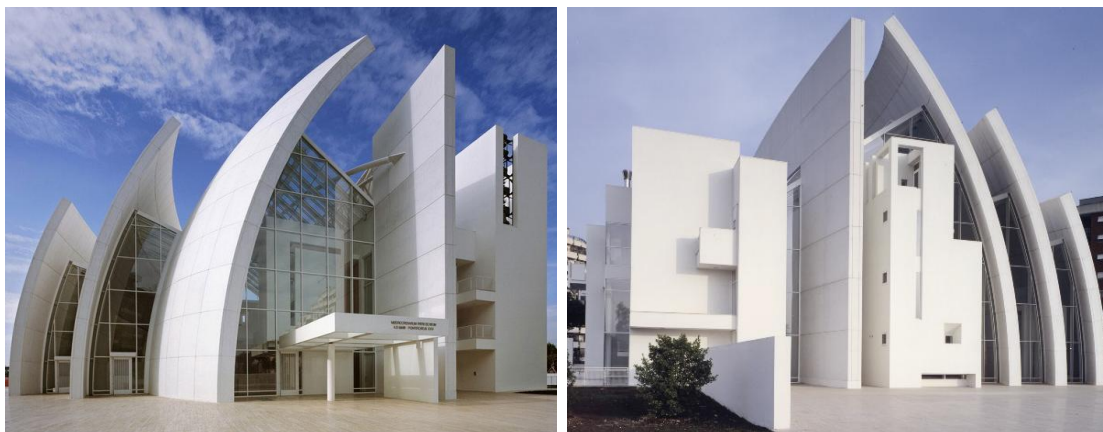
Figura 2: Fachada frontal y trasera de la iglesia Dives in Misericordia hecha con concreto fotocatalítico (Lisbona García, L. 2016)
