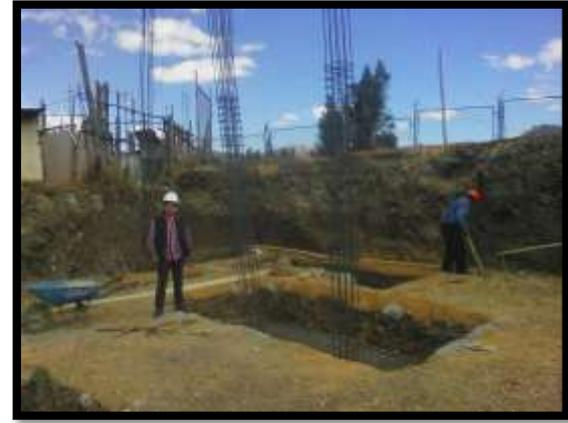
*Colocación de acero de refuerzo en zapatas Z-ASC-ESC*
