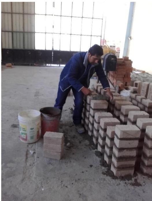
**Fig. 21** Proceso de construcción de pilas.
