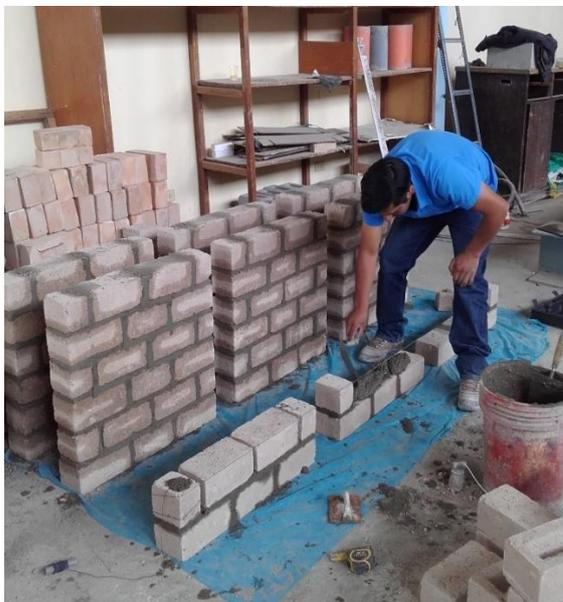
*Fig. 29 Proceso de construcción de muretes.*
