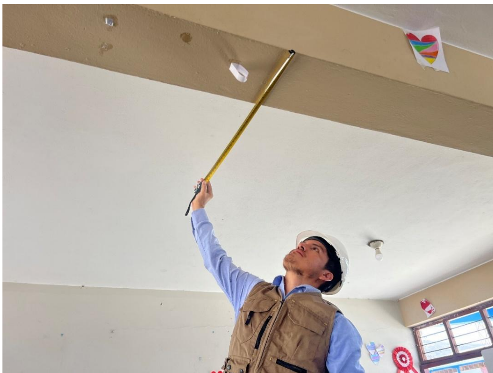
Figura 99. Se verificaron medidas de las vigas, y elementos estructurales en el levantamiento realizado insitu
