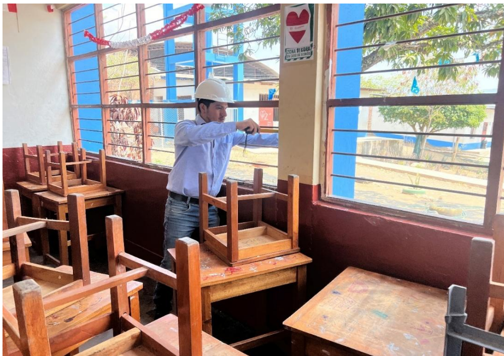
Figura 98. Se verificó medidas de los elementos estructurales en comparación a los planos alcanzados del Exp.Técnico en físico
