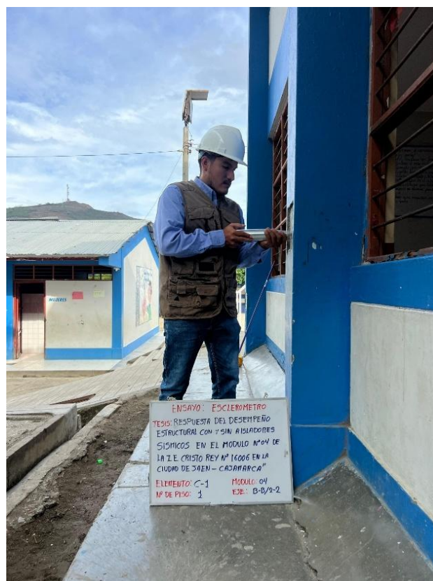
Figura 104. Se realizó el ensayo no destructivo con esclerómetro, en columnas del bloque educativo que fue analizado
