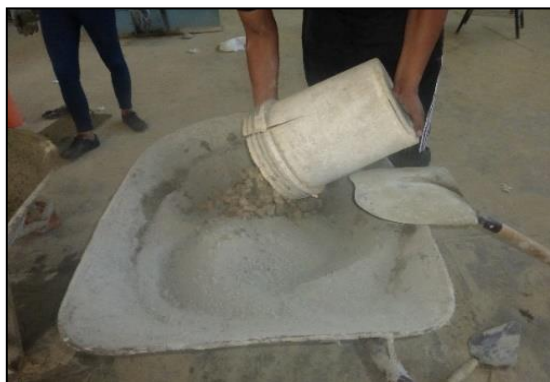
Fotografía 9. Mezcla de los materiales para la elaboración de los especímenes de concreto.
