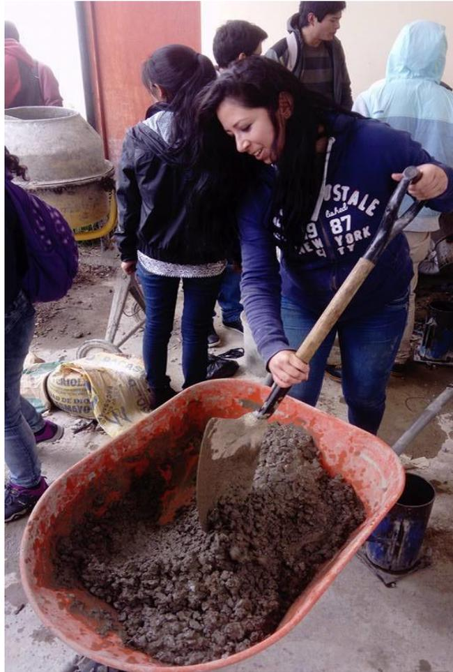
*Imagen N° 4: Fotografía de la mezcla manual de la tanda de prueba*
