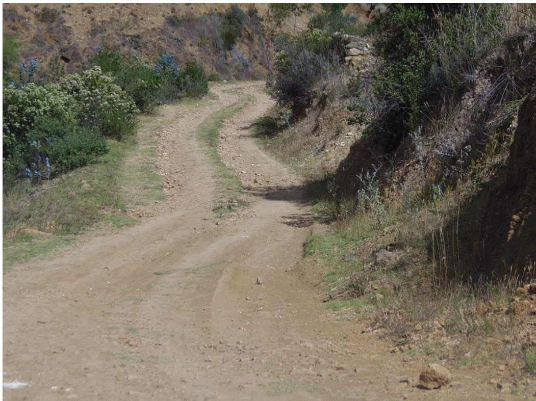
Fotografía N° 12 Sinuosidad de la Carretera
