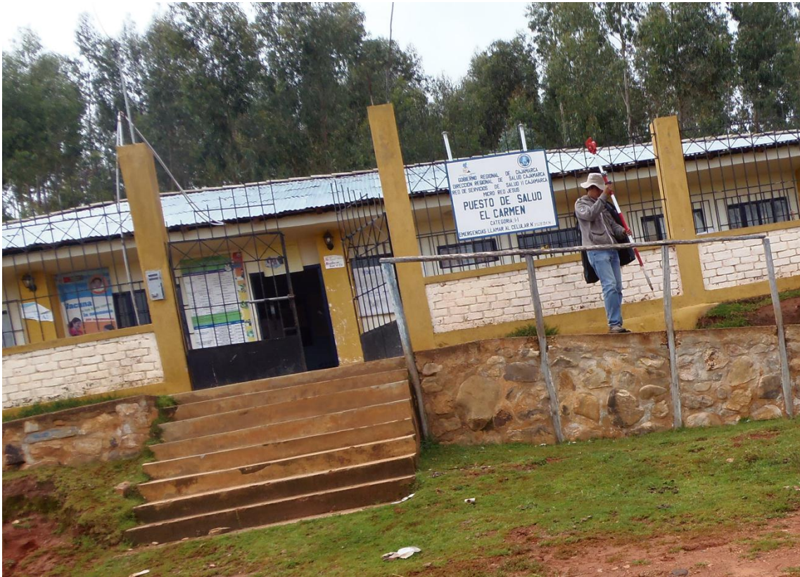
Fotografía N° 13 Puesto de salud El Carmen
