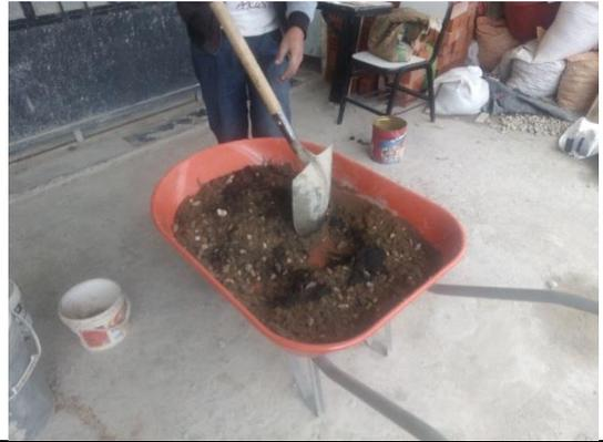
**Imagen N°10.-** Elaboración de la mezcla de concreto.
