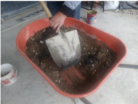
**Imagen N°11.-** Elaboración de la mezcla de concreto.
