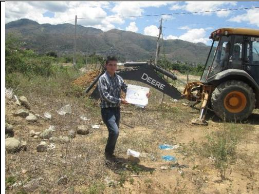
Excavación a 4.00 de profundidad, presenta dos estratos, no se observa N.F a esta profundidad, se tiene en cuenta 3.00 de desnivel respecto C5.
