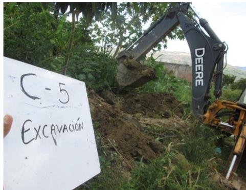
Excavación a 2.00 de profundidad, presenta dos estratos, donde C5-M2 se observa N.F a -1.50 m, muy cerca a nivel de cimentación.
