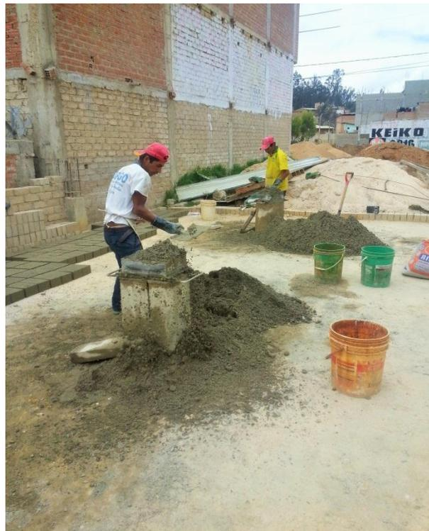
Figura 49. Proceso de fabricación del ladrillo de concreto
