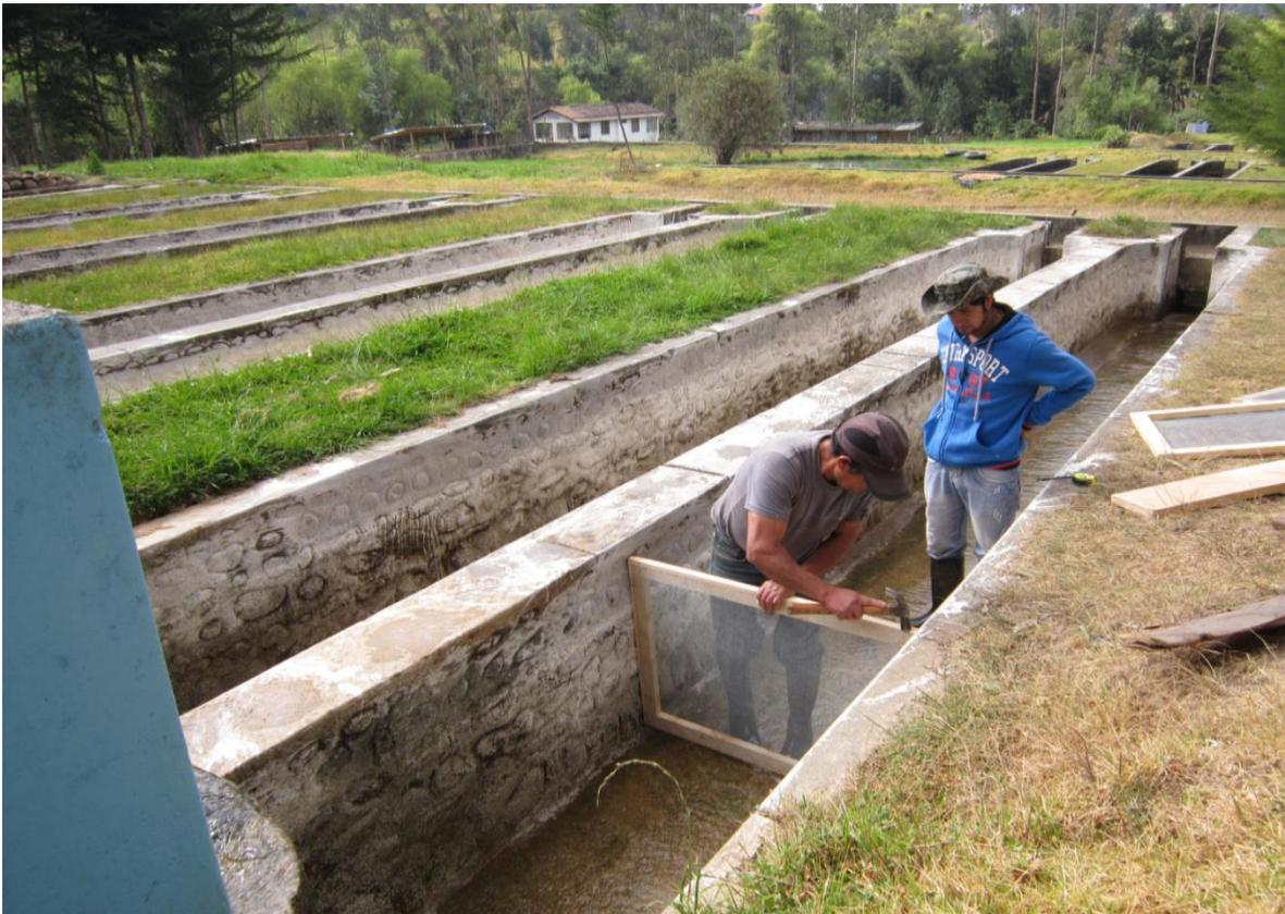
**Figura 2.** Acondicionamiento de estanques experimentales: área 2 m<sup>2</sup> por estanque
