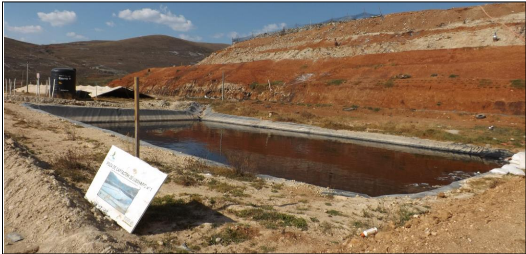
Figura 4. Poza de almacenamiento de lixiviados del relleno sanitario Cajamarca.
