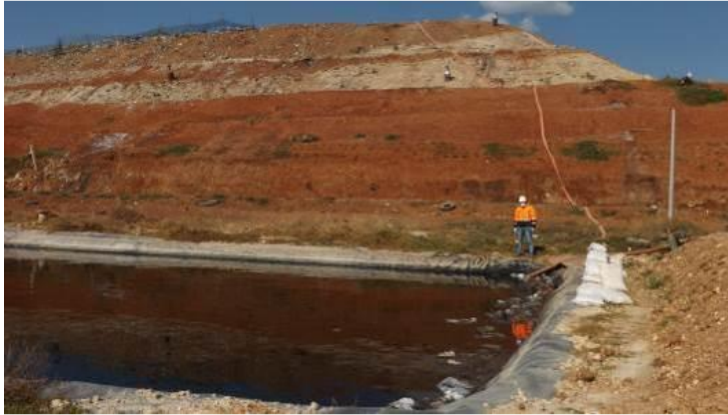
Figura 1. Reconocimiento del Relleno Sanitario de Cajamarca – Poza de lixiviado generados en la celda de residuos municipales
