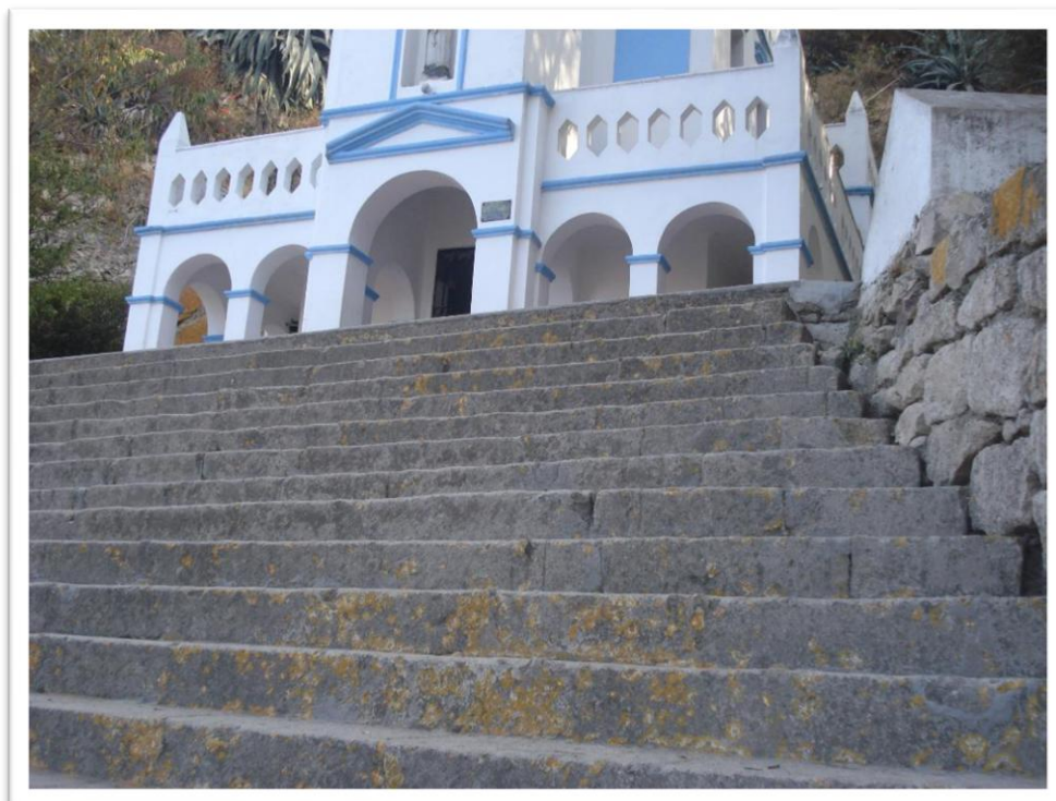
Figura 23. Líquenes saxícolas sobre la mampostería en el sitio arqueológico Santa Apolonia
