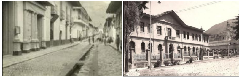
Figura 1: Situación de la infraestructura vial de Cajamarca en el siglo XVIII. Izquierda Jr. El Comercio, a la derecha Av. El Maestro.
