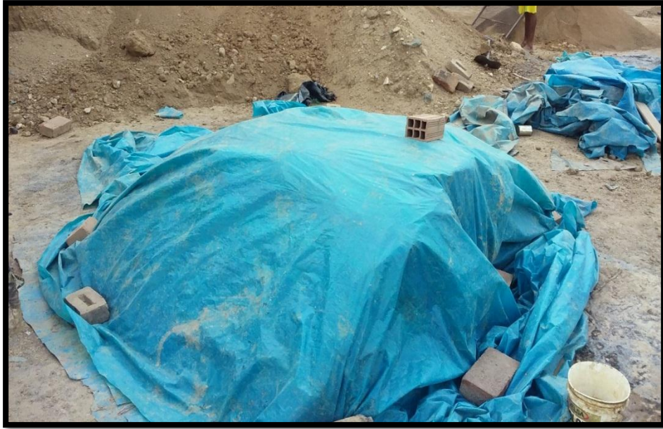
FIGURA 10: CURADO DE LA MEZCLA.
