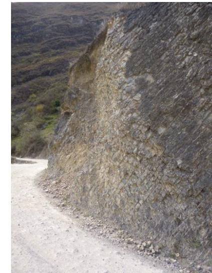
Foto de Talud.
