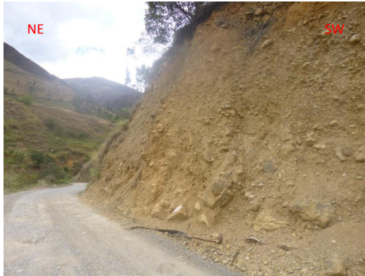
Foto 20: Depósito Coluvio – Aluvial, Km 21.
