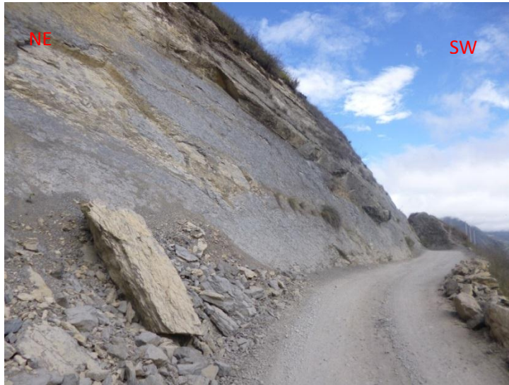
Foto 16: Afloramiento rocoso de Grupo Crisnejas – Carretera Paccha – Bambamarca Km.28.
