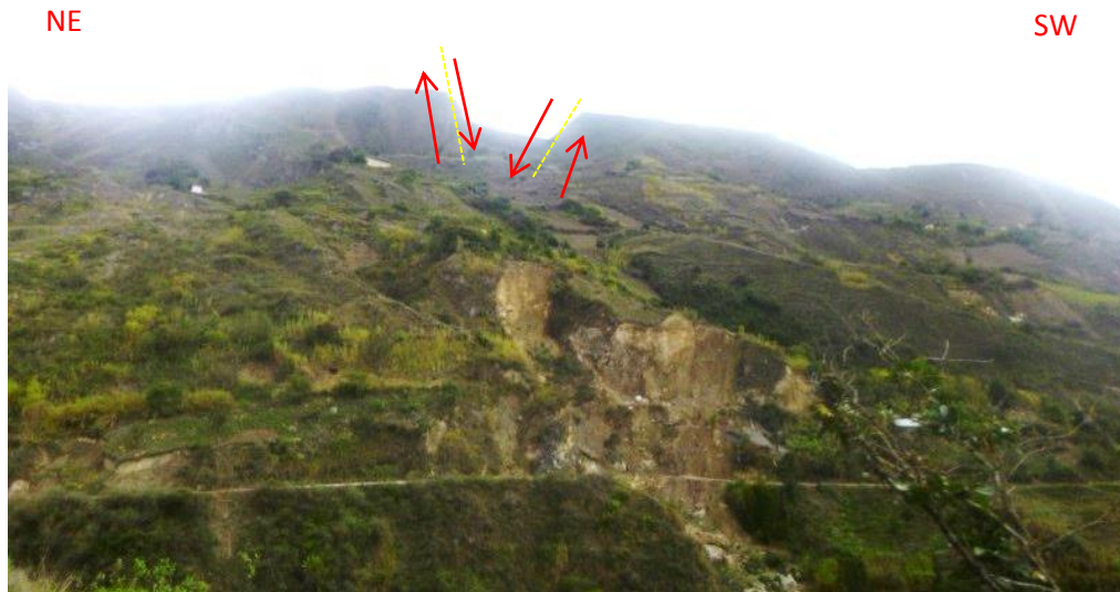
Foto 23: Falla tipo Graven sobre calizas, Km 29.
