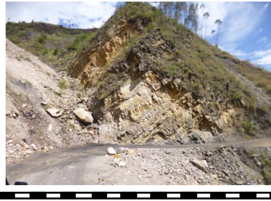
Fotografía de detalle del Macizo Rocoso.
