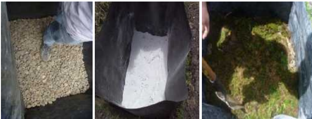
Foto 4: Colocando grava, cal y la materia orgánica a los sistemas de tratamiento
