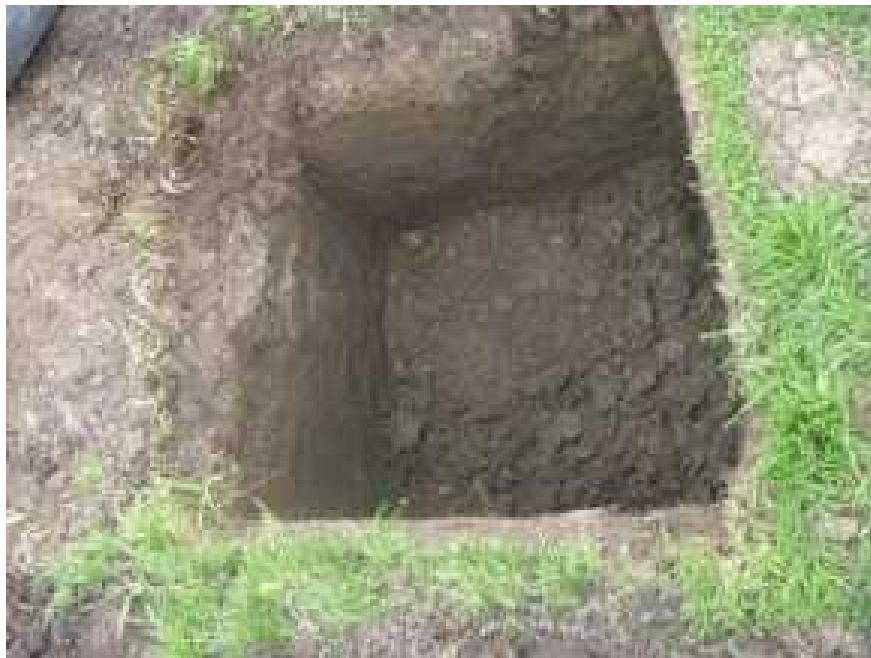
Foto 2: Excavación concluida para los sistemas de tratamiento
