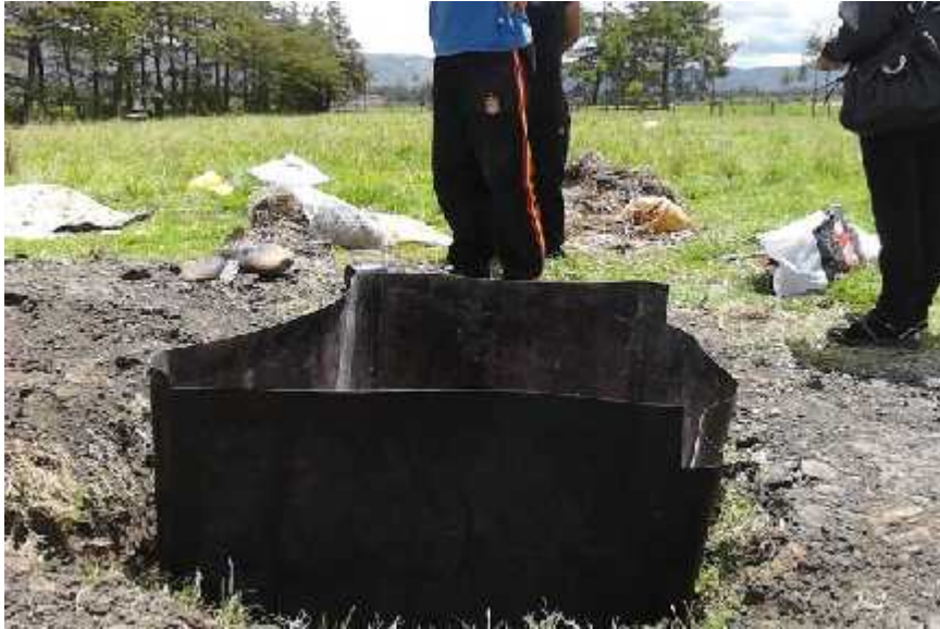
Foto 3: Colocando las geomembranas a las excavaciones
