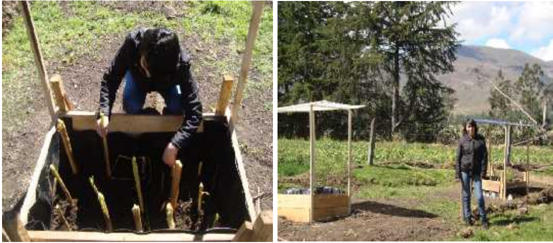
Foto 6: Los dos sistemas de tratamiento concluidos
