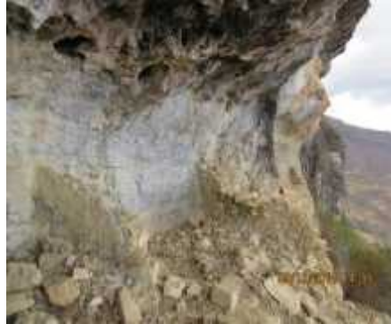
Foto 50. Restos construcciones el filo
