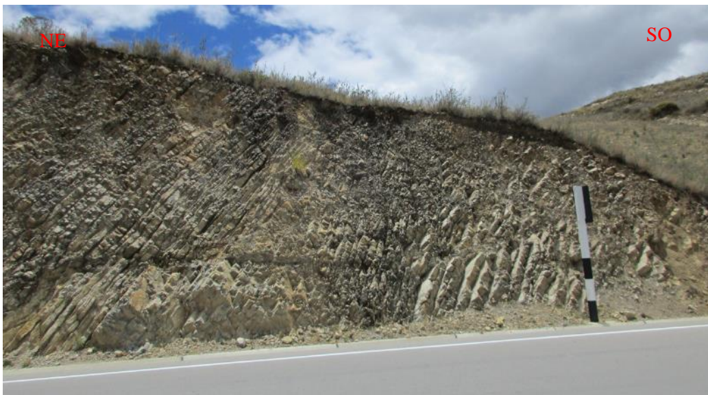
Figura 9: Estratos de caliza intercalada con estratos de lutitas del Ki-Pa en el Km 36+300.
