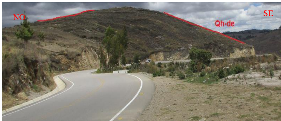
Figura 12: Vista de depósitos deluviales en las laderas de los cerros Usnio y torre en el Km 38+200.
