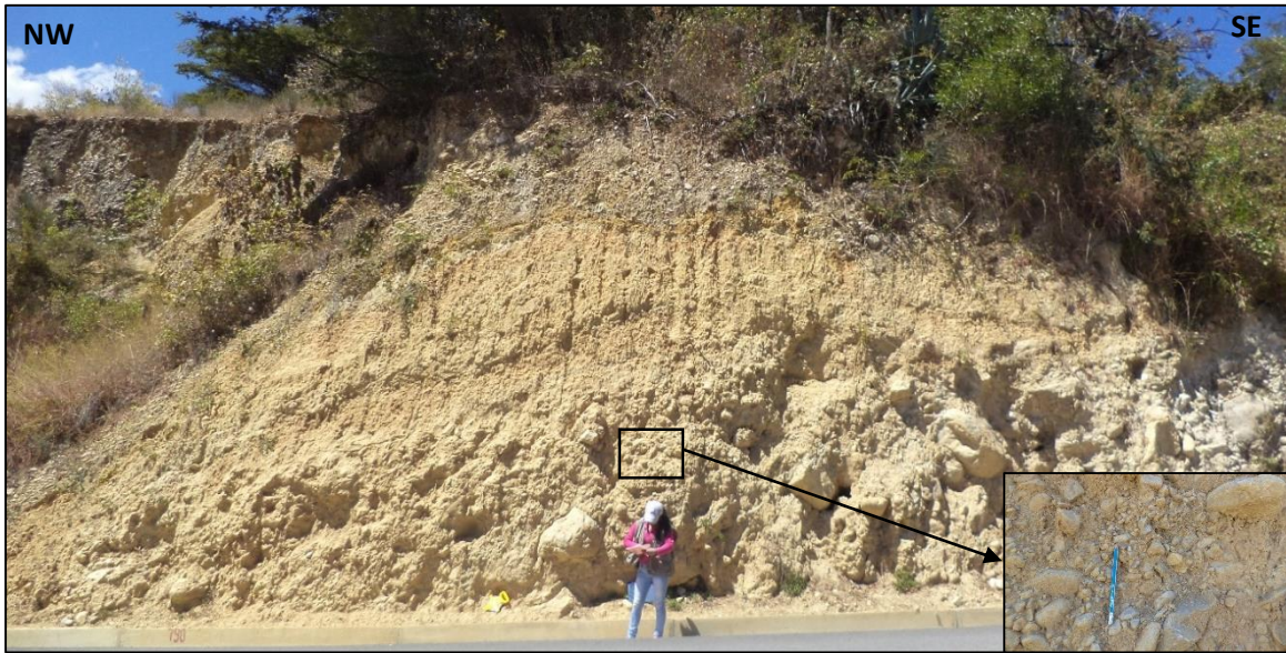
Foto N° 19: Talud suspendido, en conglomerado de areniscas con matriz arenosa pardo amarillenta.
