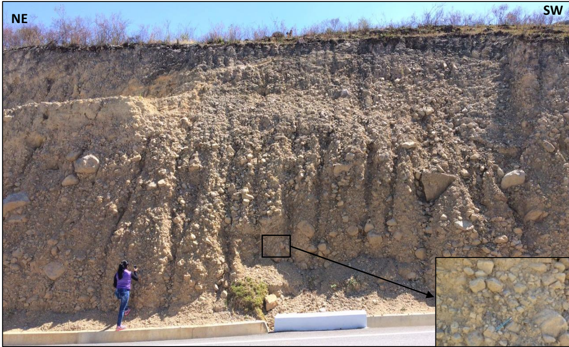
Foto N° 17: Talud suspendido en conglomerado de arenisca con clastos calcáreos en una matriz arenosa; con presencia de pequeñas cárcavas.
