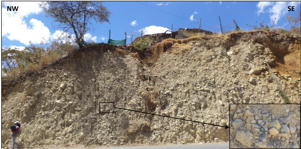
Foto N° 14: Talud suspendido en conglomerado de areniscas y clastos calcáreos con tamaños heterogéneos en una matriz arenosa.
