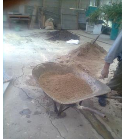
Figura 10. Lavado de arena de cerro
