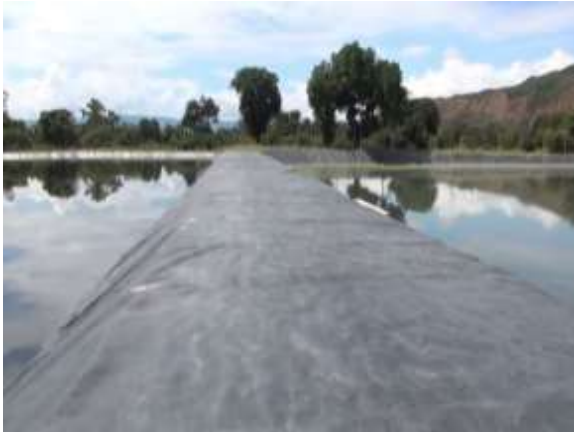
Foto 01: Lagunas de oxidación – E.P.S. Marañón.
