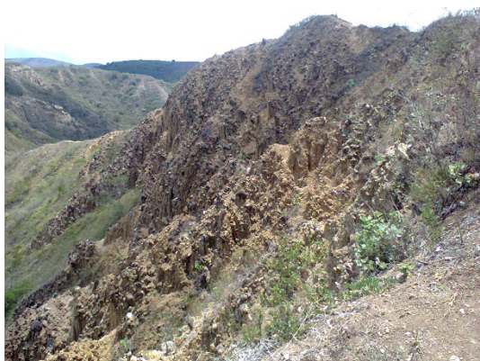
Foto 14. Zonas erosionadas – sector Fila Alta
