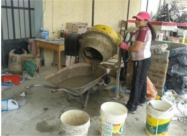
**Figura N° 50:** mezcla de concreto autocompactante con la dosificación D-4
