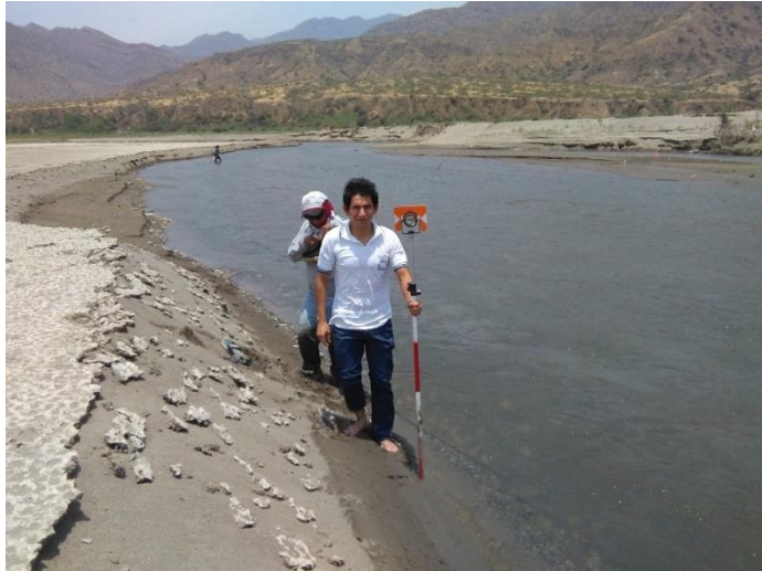
Imagen 8 Levantamiento Topográfico del Tramo de entrega.
