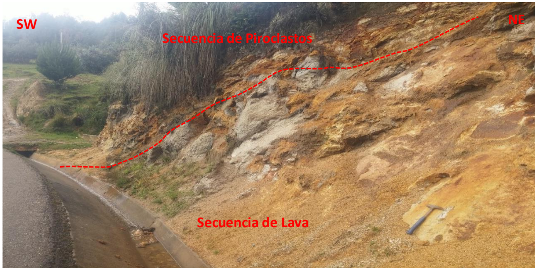
Figura 16: Se evidencia dos secuencias Volcanicas en el corte de Carretera Cajamarca-Bambamarca en margen izquierdo: una secuencia superficial de piroclastos de un espesor aproximado de 180m, con un color pardo amarillo producto de la erosion; la otra secuencia de lava coherente masiva es de un color gris blanquesina, con presencia de pirita, ademas la parte superficial es de un color amarillento, producto de la alteracion. Referencia Km. 20 +200.
