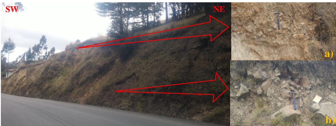
Figura 23: Se aprecia en corte de carretera Cajamarca – Bambamarca, margen derecho de la parte superior (a) se puede apreciar un horizonte de fragmentos de roca angulosos a subangulosos de tamaño aproximado entre 4 - 10cm. En la parte inferior (b) se puede apreciar fragmentos angulosos de un tamaño aproximado hasta 80cm. Referencia Km. 19+000.
