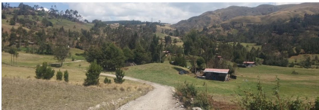
Figura 8: Se aprecia Carretera afirmada, ubicada en el Caserío de Chilimpampa Baja.
