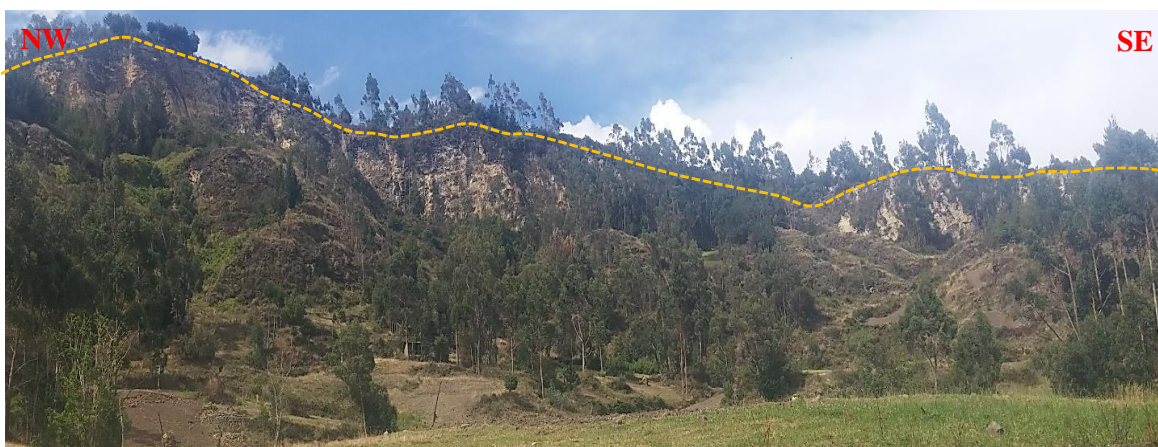
Figura 26: Se evidencia la presencia de un escarpe estructural, en vista frontal de la estructura que tiene una longitud aproximadamente 1.8 km.
