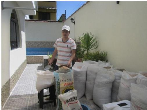
Imagen N°4. Fotografía de tamizado de agregado con la Malla # 3/8.
