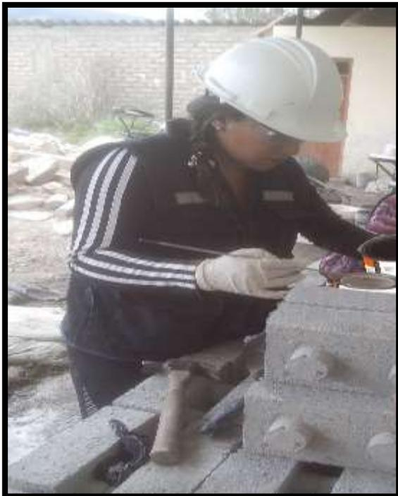
**FOTO N°40:** Preparación del adhesivo epóxico, según las proporciones indicadas.
