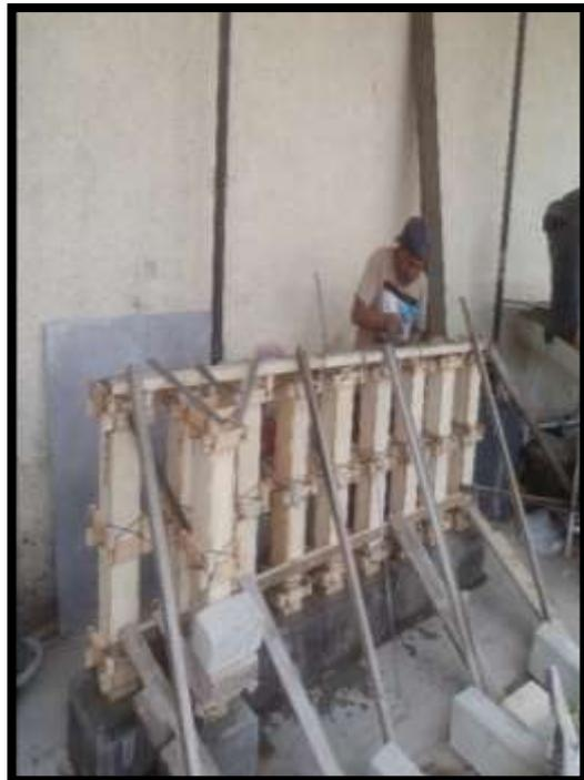
**FOTO N°33:** Vaciado de columnetas núcleo, con concreto  $f'c = 175$  kg/cm<sup>2</sup>.
