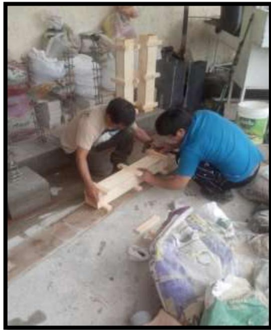
**FOTO N°31:** Armado de encofrados de triplay (e=12mm) de columnetas núcleo.
