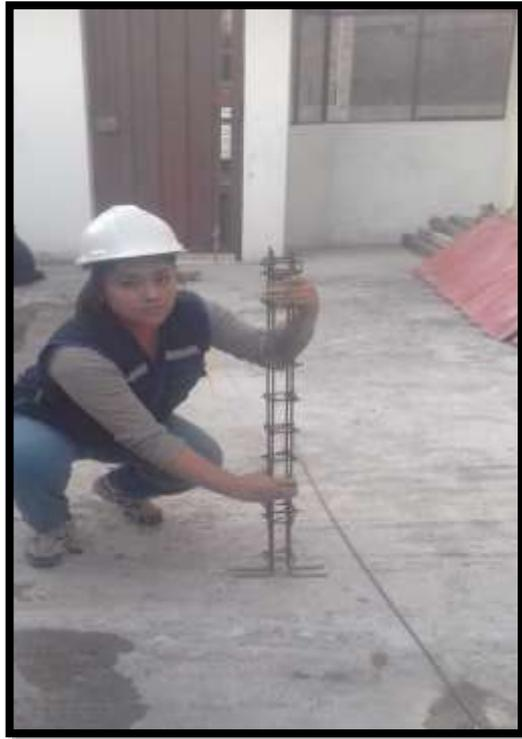
**FOTO N°22 Y 23:** Armado de la armadura de acero de columnetas núcleo.
