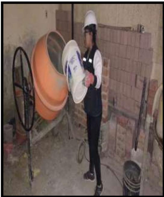
**FOTO N°44:** Preparación de la mezcla con concreto  $f'c = 225 \text{ kg/cm}^2$  para el posterior vaciado del encamisado.
