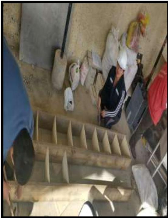
**FOTO N°24:** Armado de encofrados de madera para zapatas.
