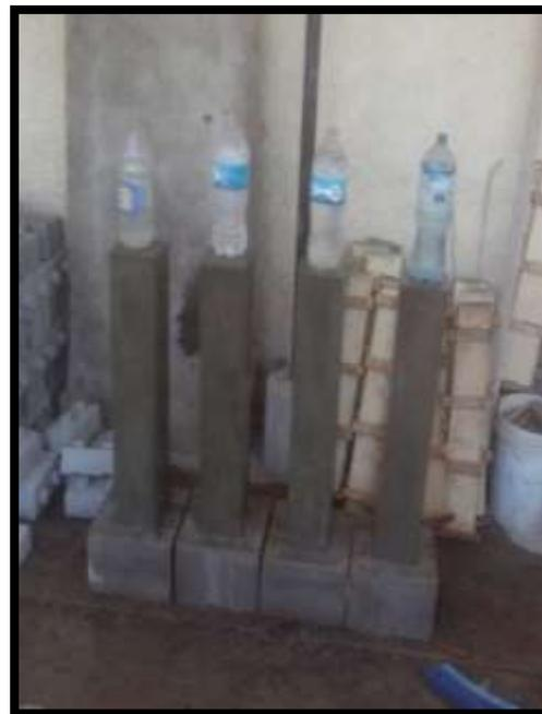
**FOTO N°45:** Curado por goteo de las columnetas encamisadas.
