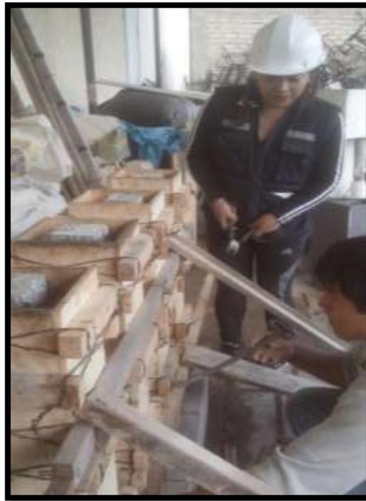
**FOTO N°43:** Colocación del encofrado de triplay (12mm) del encamisado.
