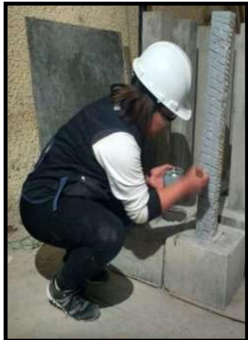
**FOTO N°41:** Aplicación de adhesivo epóxico.
