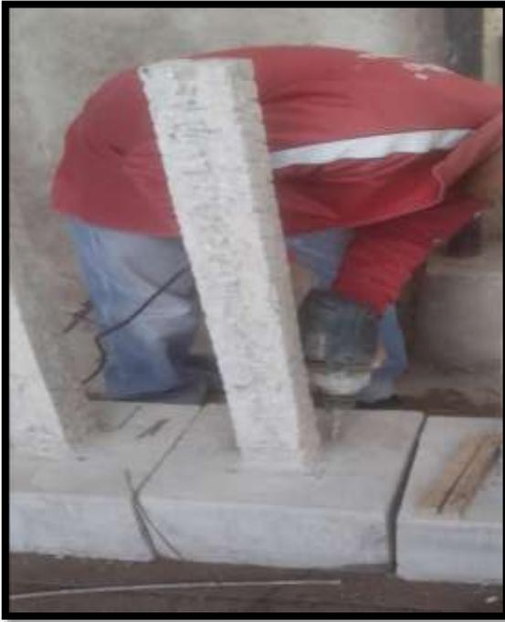
**FOTO N°38:** Perforación de zapata para anclaje de la armadura de acero del encamisado.
