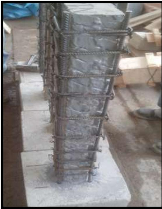
**FOTO N°42:** Colocación de la armadura de acero del encamisado.
