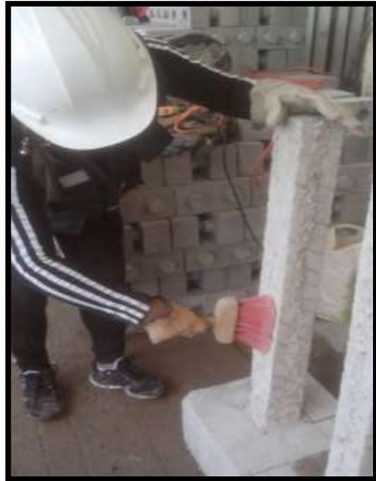
**FOTO N°39:** Preparación de la superficie de las columnetas a encamisar (limpieza).
