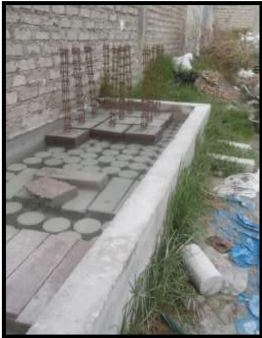
**FOTO N°30:** Curado de zapatas en la poza para curados de la UNC.
