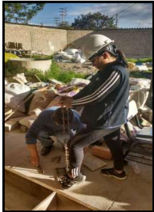
**FOTO N°25:** Armado de columnetas con sus respectivas zapatas.
