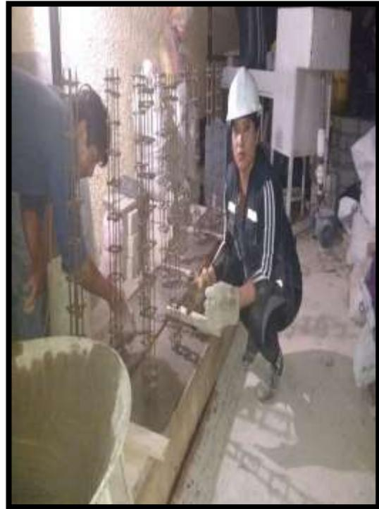
**FOTO N°27:** Llenado de zapatas con concreto  $f'c=175 \text{ kg/cm}^2$ .
