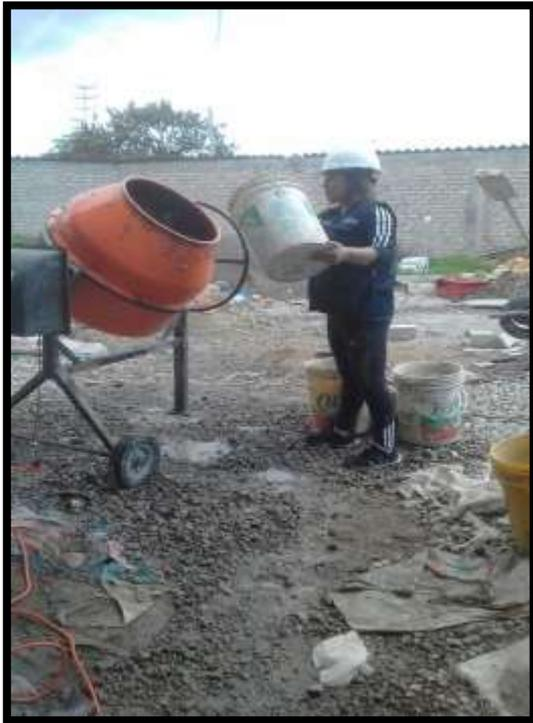
**FOTO N°26:** Preparación de mezcla de concreto ( $f'c=175 \text{ kg/cm}^2$ ) para llenado de zapatas.
