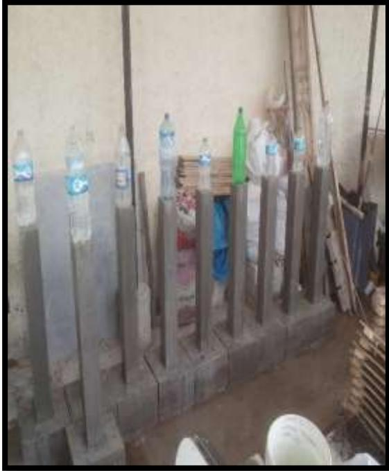
**FOTO N°34:** Curado por goteo y rociado de columnetas núcleo.
