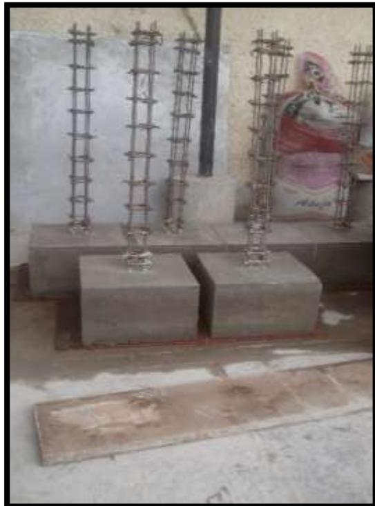
**FOTO N°28 y 29:** Desencofrado de zapatas previa supervisión del asesor de tesis.
