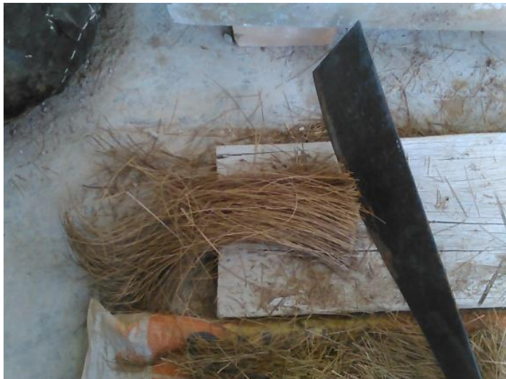
Figura 5. Recorte de la paja para la mezcla con el barro.
