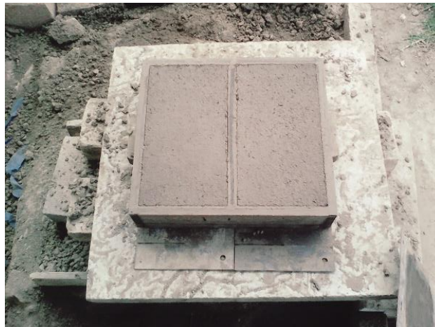
Figura 11. Bloques de adobe antes del desencofrado
