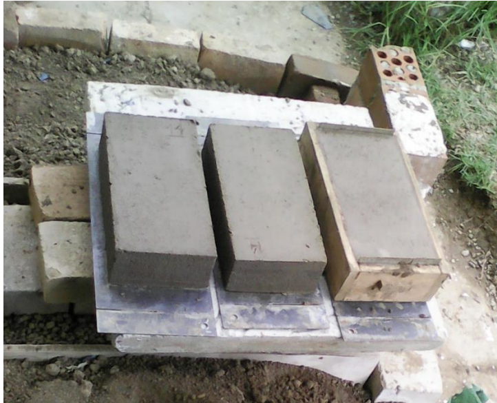
Figura 13. Bloques de adobe recién desencofrados.
