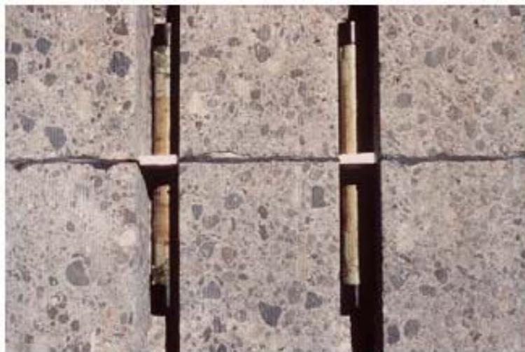
**Figura 2.28** Reparación de espesor parcial
