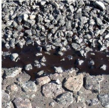
**Figura 2.9.** Macro textura usada para heladas en Colorado
