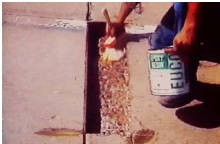
**Figura 2.26.** Aplicación de puente de adherencia en reparación
