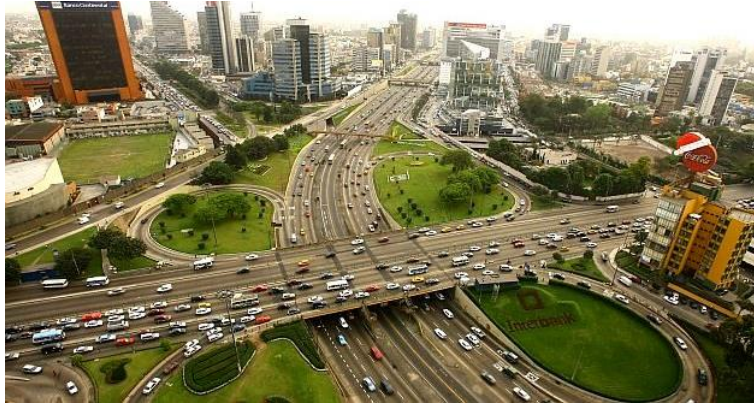
Figura N° 2. 7: Vista del trébol de Av. Javier Prado y Av. Paseo de la República, Lima - Perú
