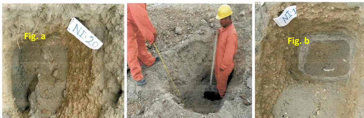
Figura b. Excavación de calicatas/Estructura del suelo, suelo con pedregoso de \varnothing < 2' en 80%.
