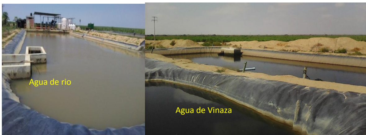
Figura 10. Reservorio de agua para riegos en el DPS10.
