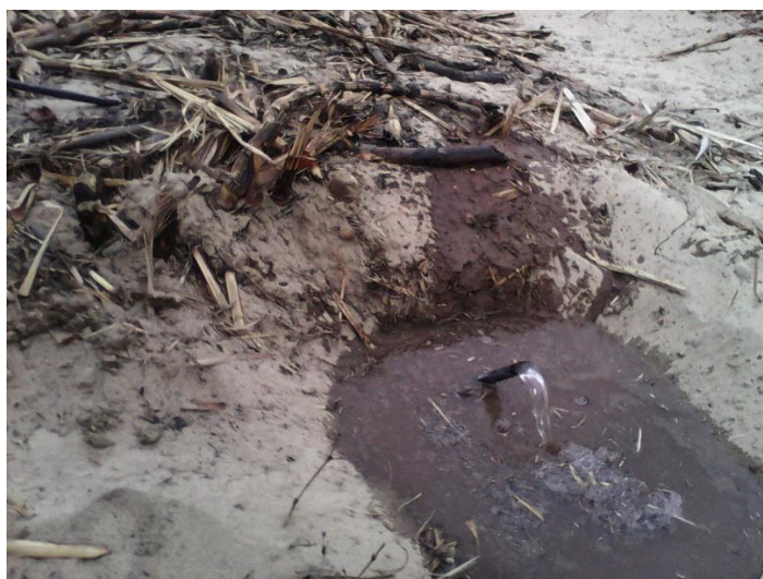
Foto 9. Autopurga de los laterales en la subunidad "A"
