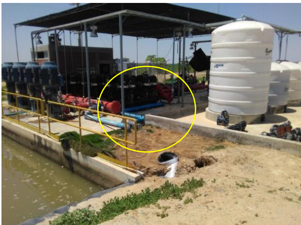
Figura 12. Tubería de conducción y distribución de agua para riego
