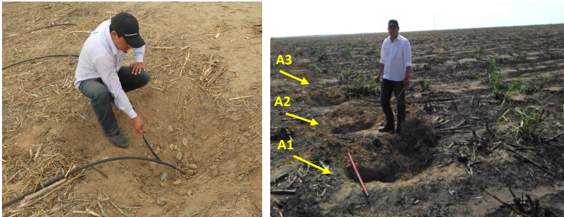
Figura 23. Desenterrado de los laterales que sobre pasa el diseño.
