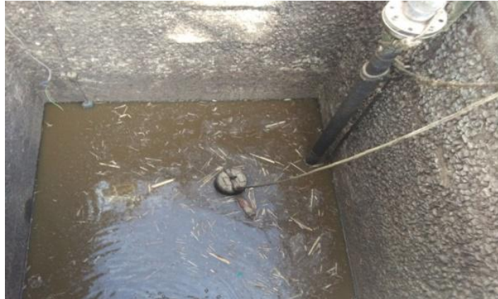
Figura 11. Salida de Vinaza del micro reservorio
