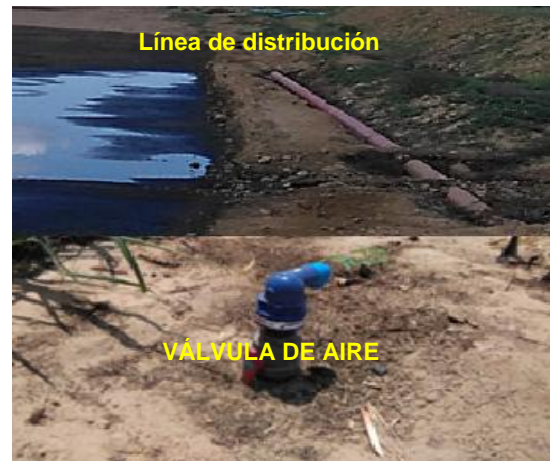
Figura 12. Tubería de conducción y distribución de agua para riego
