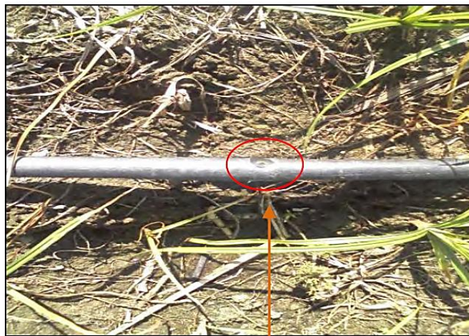
Foto 5. Ubicación correcta del gotero salida del agua hacia arriba.
