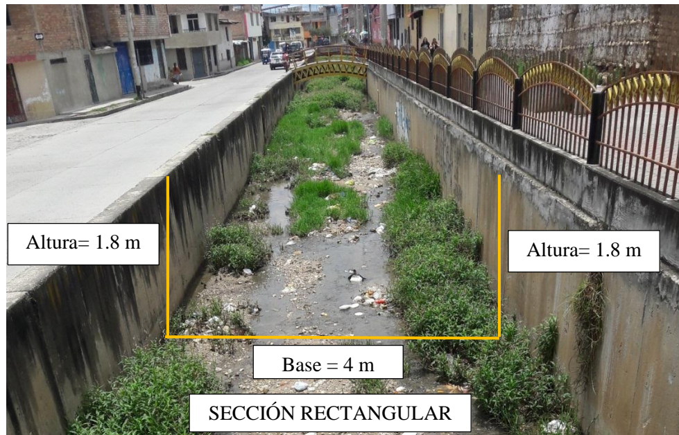
Figura 24: Medidas tomadas en campo del canal de la quebrada Calispuquio – tramo Prolongación Progreso – Av. San Martín
