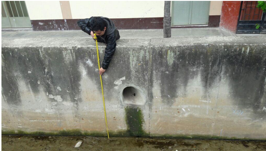
Figura 20: Foto de toma de medidas en campo del canal de la quebrada Calispuquio – Av. San Martín
