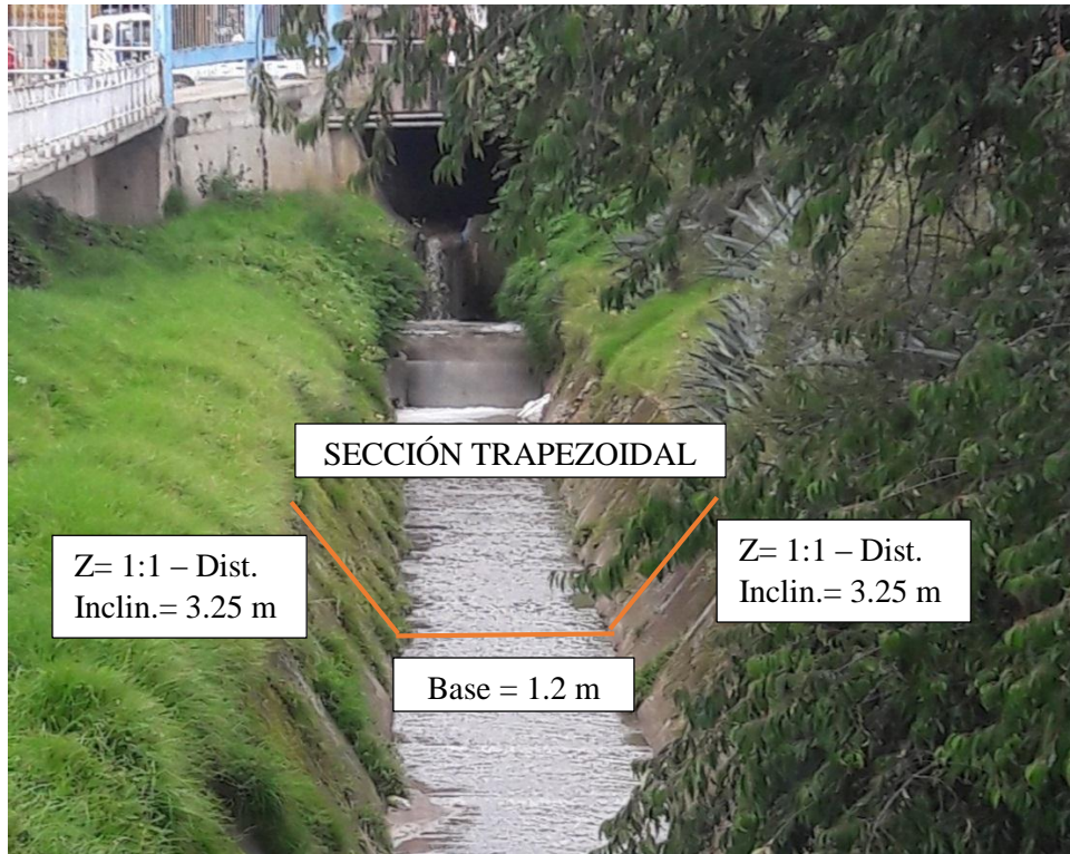
Figura 22: Medidas tomadas en campo del canal de la quebrada Calispuquio – tramo UNC
