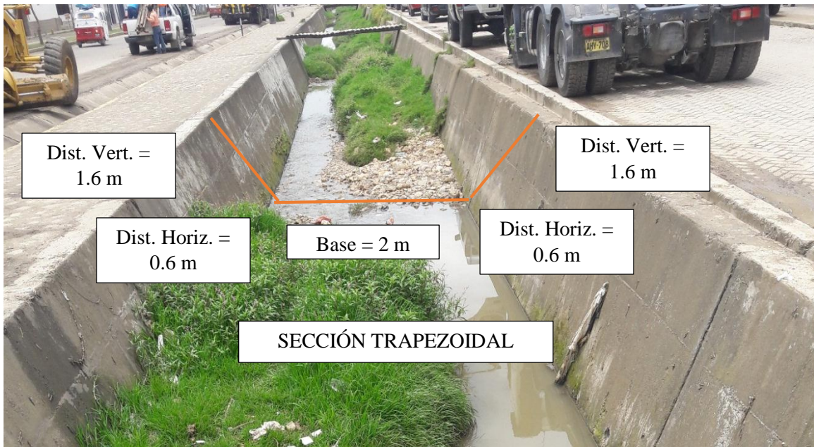
Figura 23: Medidas tomadas en campo del canal de la quebrada Calispuquio – tramo Vía de Evitamiento Sur y Prolongación Progreso
