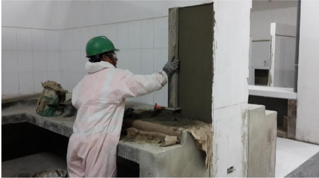
**Figura 10:** Doble proceso de trabajo, tarrajeo de columna después de haber sido enchapada con cerámico.
