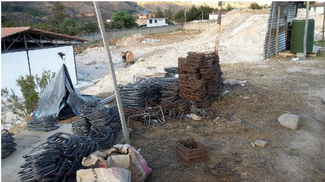
**Figura 9:** Sobreproducción en el doblado de estribos para columnas
