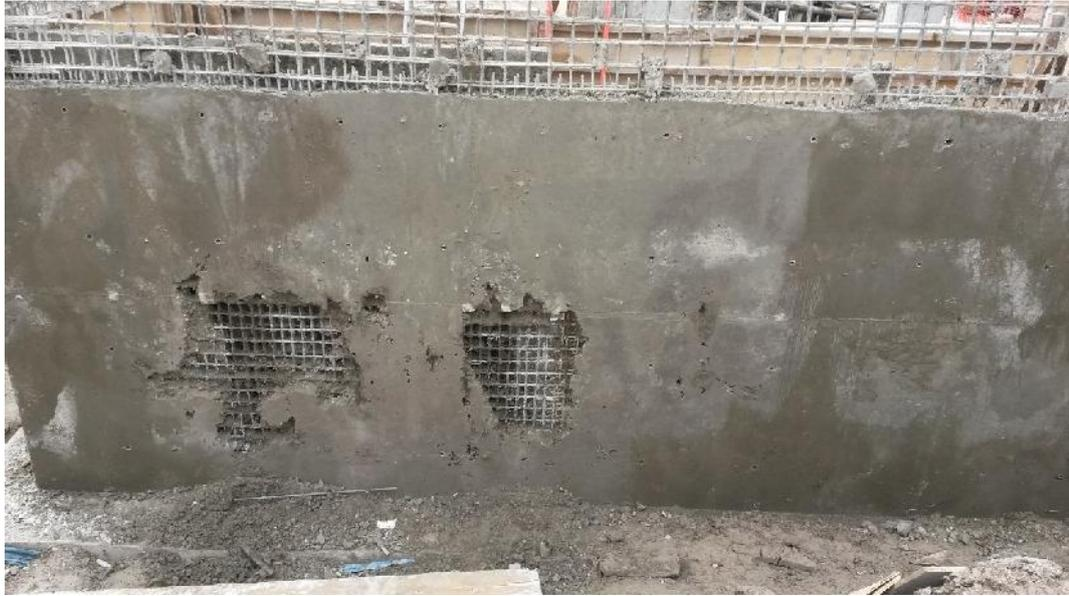
**Figura 4:** Defectos en el vibrado de concreto que han generado que en gran parte de la placa no haya ingresado el concreto
