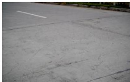
Figura 20 falla grieta retracción
