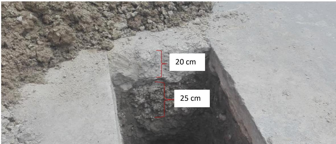
Figura 45 Descripción de la estructura del pavimento existente
