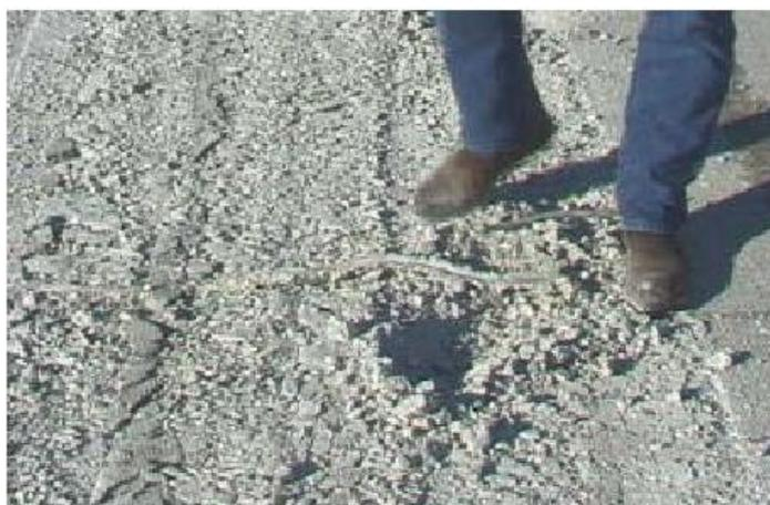
Figura 31 Losa de concreto después de ser fisurada
