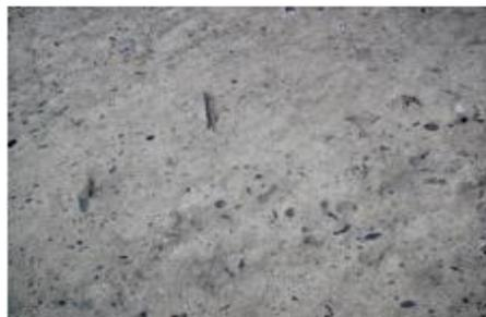
Figura 14 falla pulimiento de agregados
