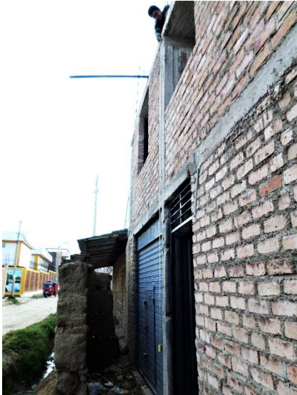
Columnas que no estan a plomo
