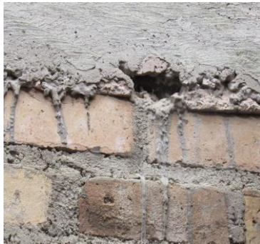
Canguerejas en vigas, exposición fierro a la intemperie
