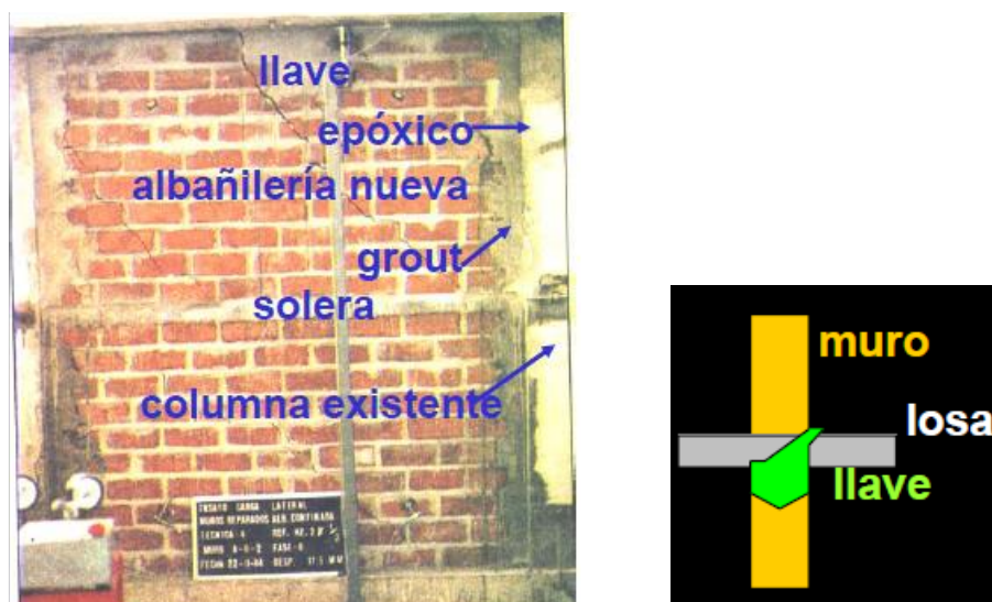
Figura 35. Modelo de muro de albañilería reemplazado
