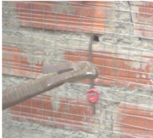
Figura 46. Colocado de conector de \varnothing ¼” doblado a 90°, fijado con clavos.
