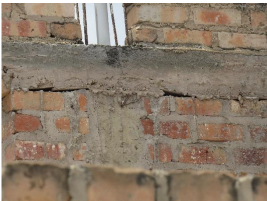
(g), (h). Unión deficiente entre muro de ladrillo y losa aligerada
