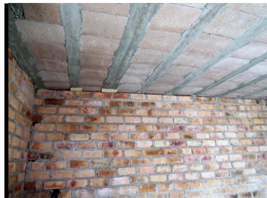
(g), (h). Unión deficiente entre muro de ladrillo y losa aligerada
