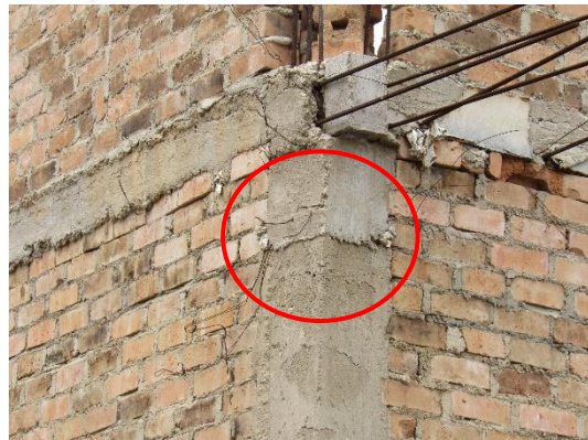
Juntas frias en columna y presencia de acero de refuerzo expuesto a la imterperie
