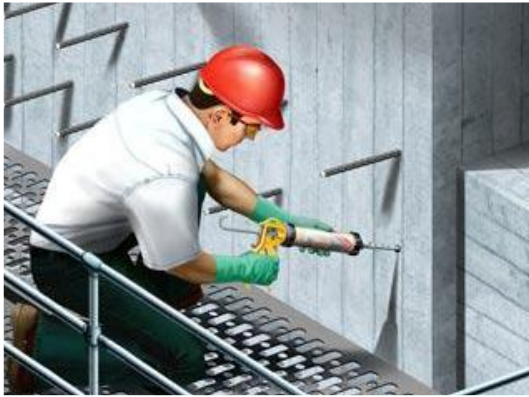
Figura 37. Colocado de pegamento epóxico.
