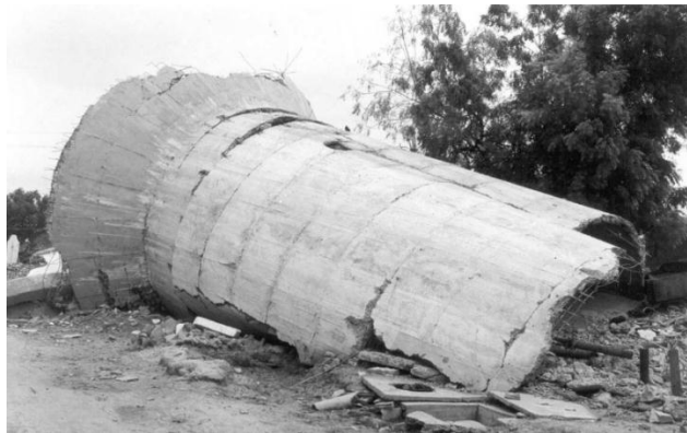
Figura 2. Reservorio elevado colapsado en el terremoto de Bhuj (Rai, 2003)
