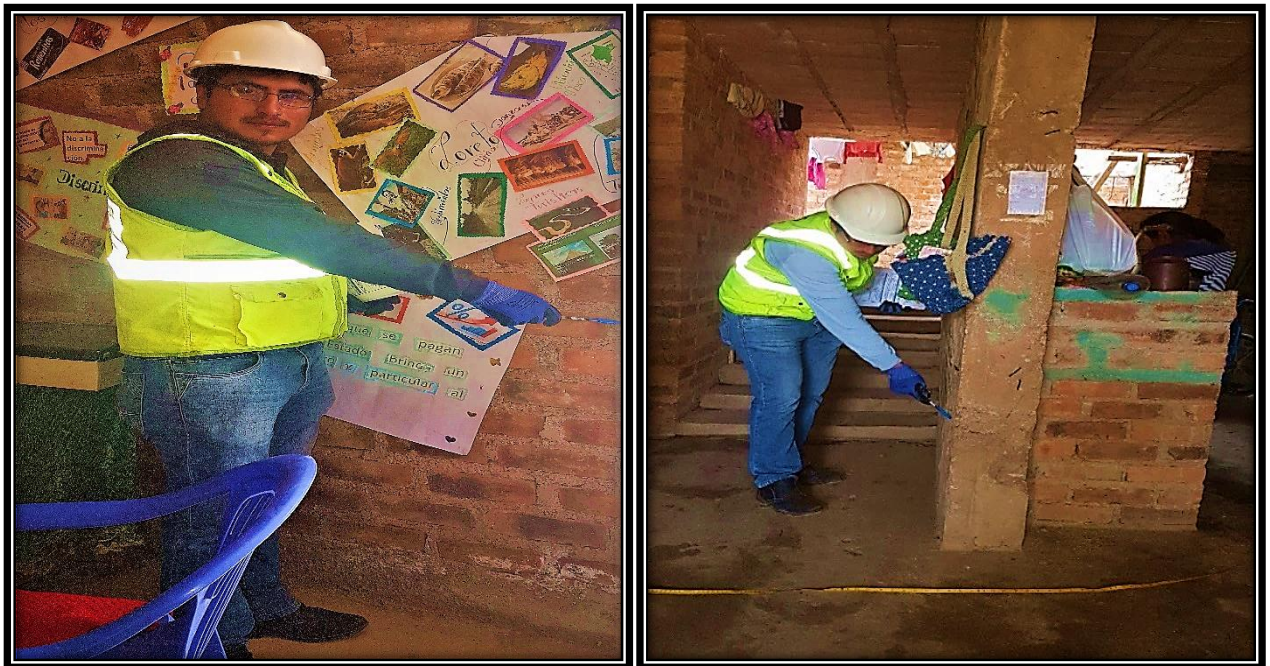
Figura N° 21 Juntas muy anchas en muros y cangrejas en columnas.
