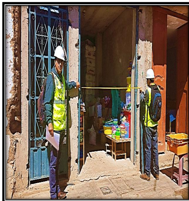
Figura N° 35 Vanos en toda la dirección de la fachada principal de la vivienda
