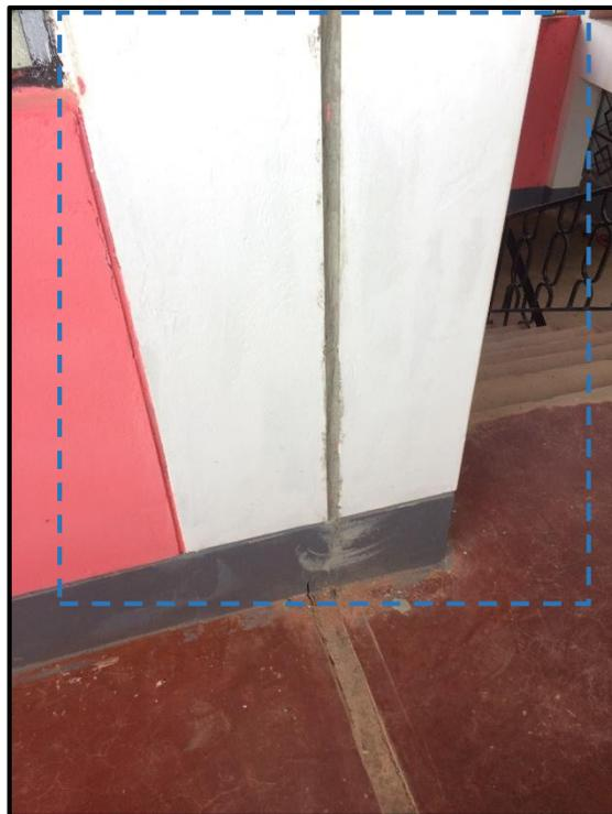
**Figura 4.28:** Vista Primer Piso - Asentamiento en el eje E y F (adjuntos a la escalera) – Pabellones Derecha – Abraham Noriega Valera
