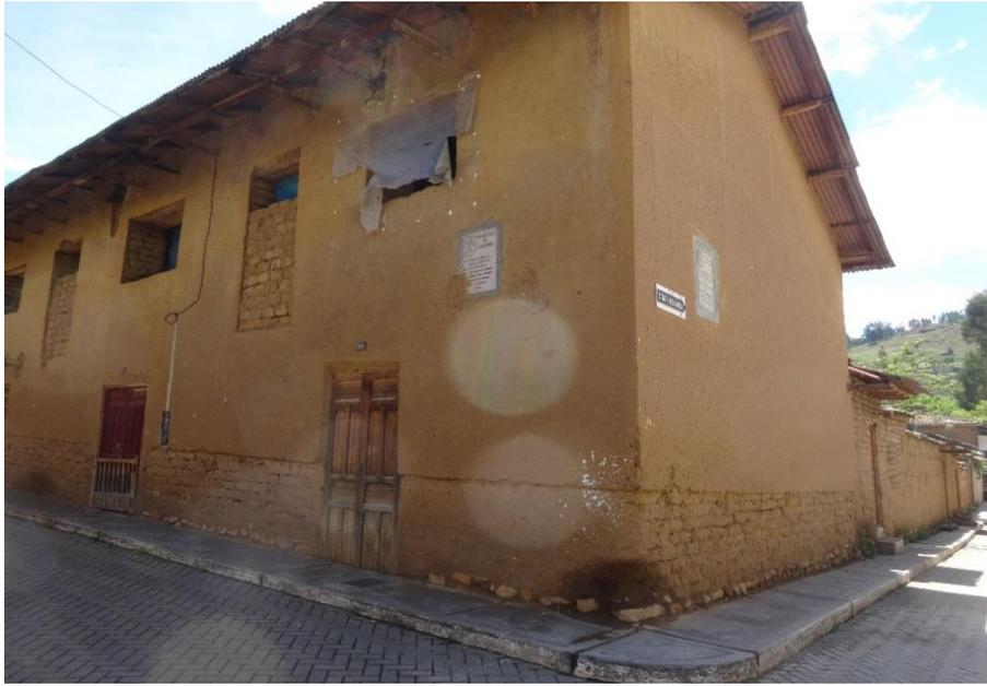
**Figura 4.7.** Edificación de adobe con excesiva separación de muros.
