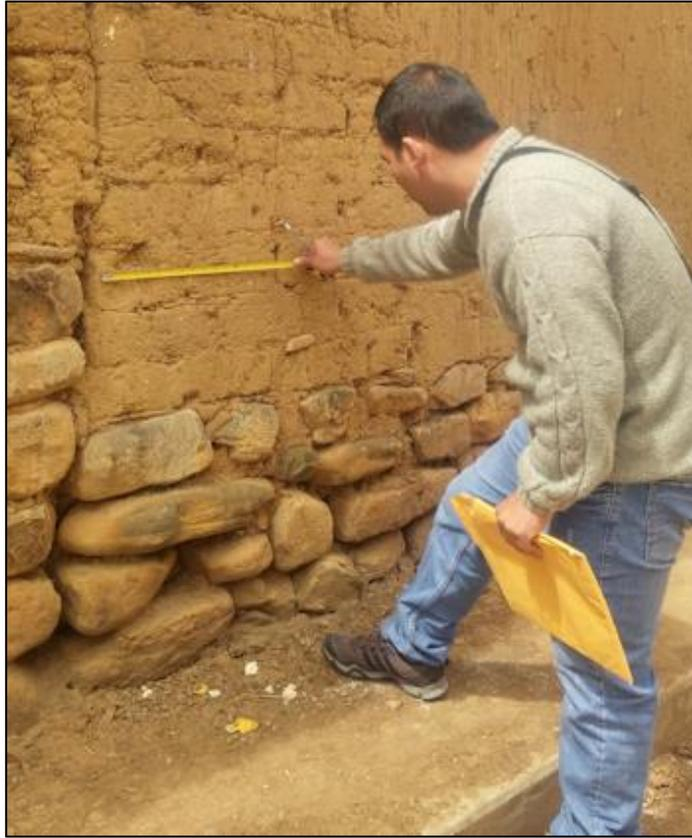
Foto N° 14: Medición de sobrecimiento y juntas entre viviendas.
