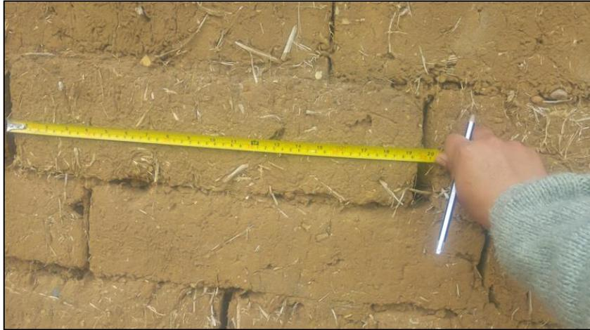
Foto N° 11: Medición de juntas y bloque de adobe.
