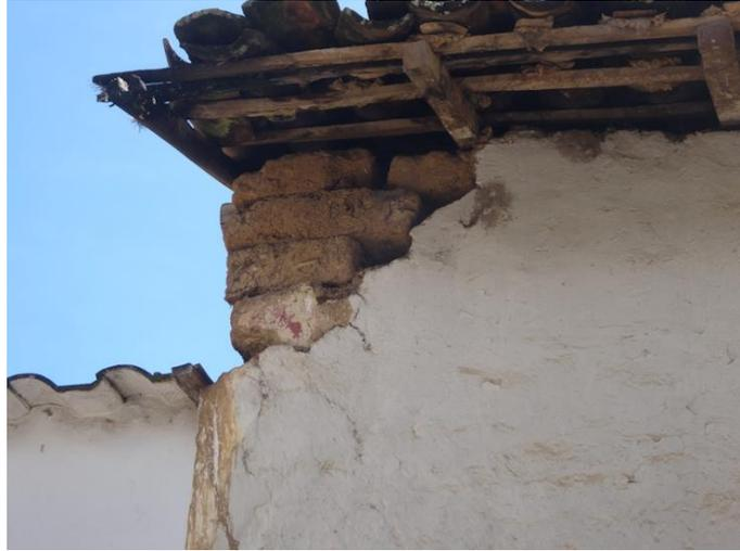
Foto N°1: Deterioro en la cobertura y muros
