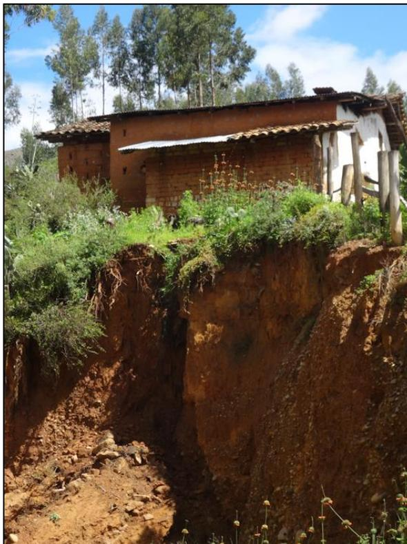
Foto N° 17: Vivienda construida en zona de ladera y con desprendimiento de material.
