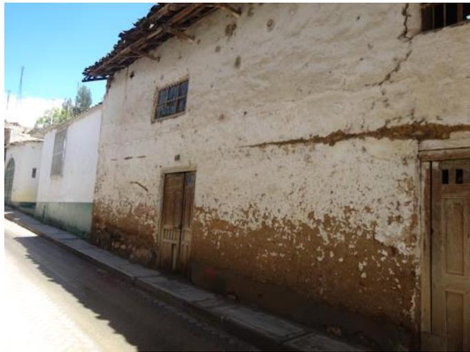
Foto N°2: Grietas y fisuras en las paredes de fachada principal
