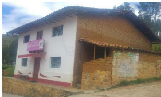
**Figura 2.7.** Muro lateral no portante.
