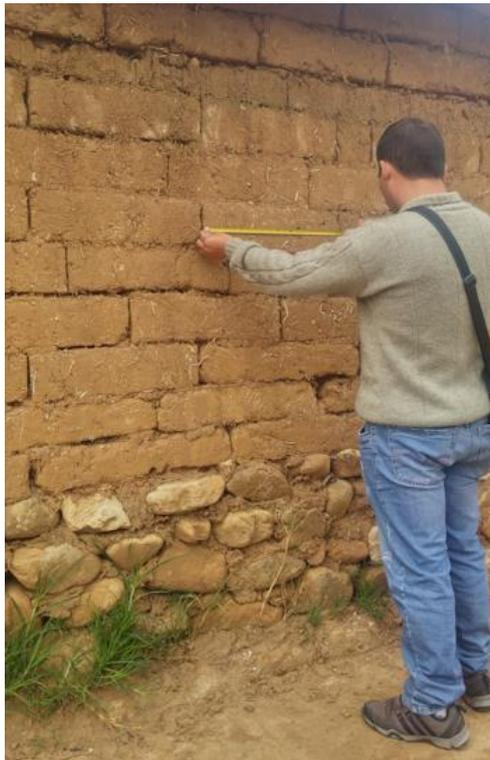
Foto N° 10: Medición de bloques de adobe construcción renovada.
