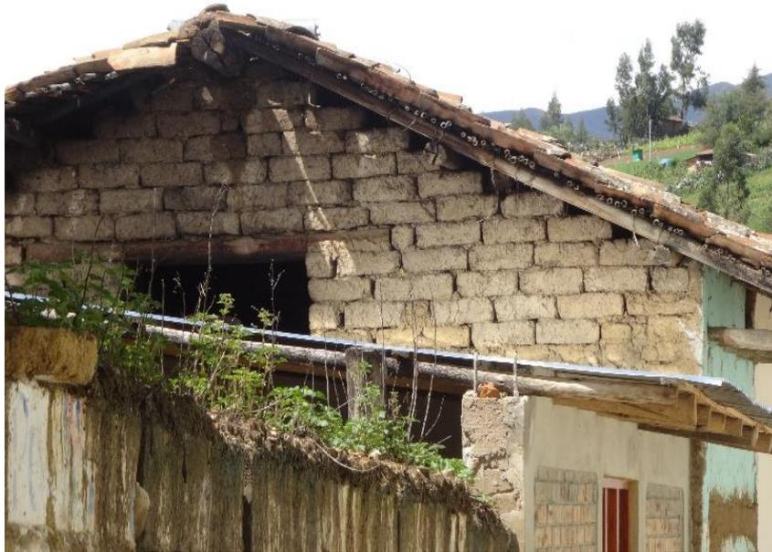
*Figura 4.5. Techo compuesto de caña y vigas de madera en estado deflectado.*
