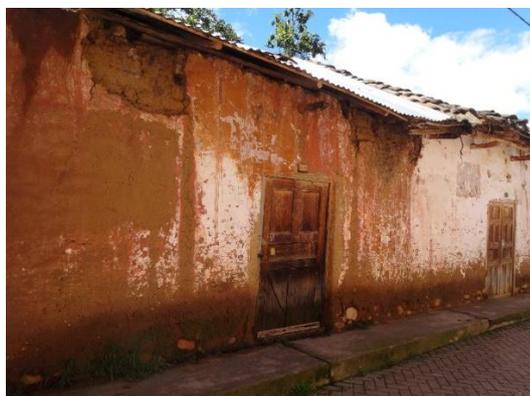
**Figura 4.4.** Presencia de humedad en el sobrecimiento y muros.
