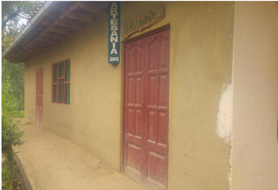
**Figura 4.1.** Edificación de adobe sin arriostramiento horizontal y vertical.
