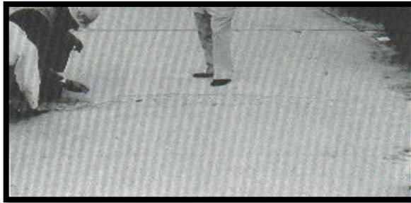
**Figura 14. Grieta de durabilidad de severidad media.**
