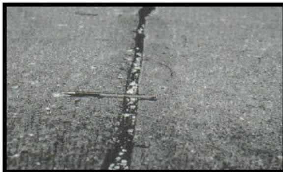
**Figura 21. Daño del sello de junta de alta severidad.**
