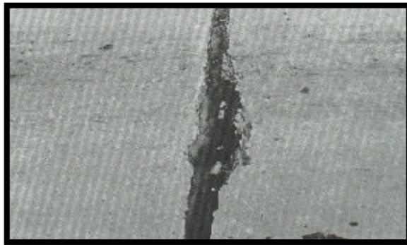
**Figura 20. Daño del sello de junta de severidad media.**
