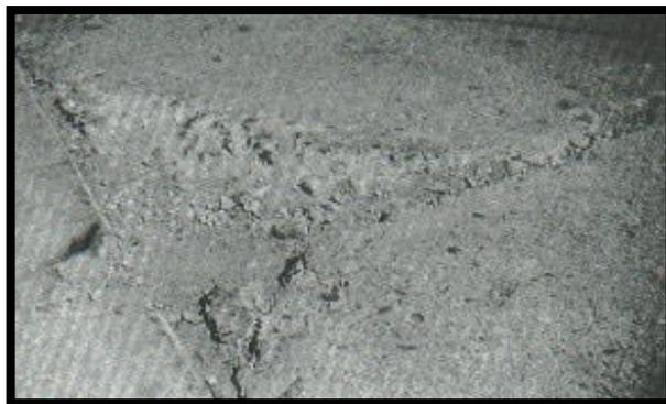
**Figura 49. Descascaramiento de esquina de alta severidad.**
