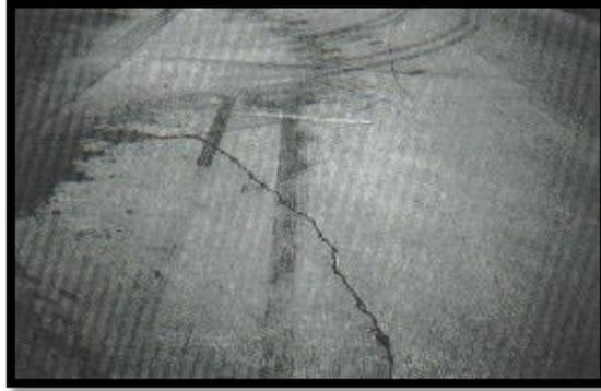
**Figura 10. Losa dividida de baja severidad.**
