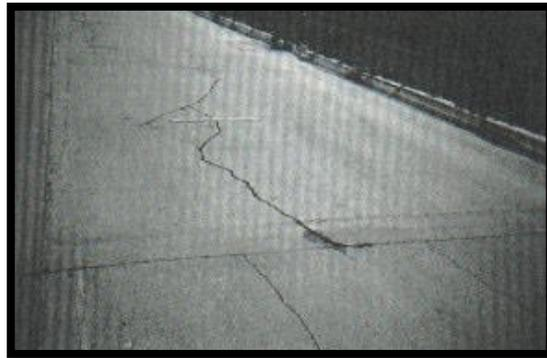
**Figura 11. Losa dividida de severidad media.**
