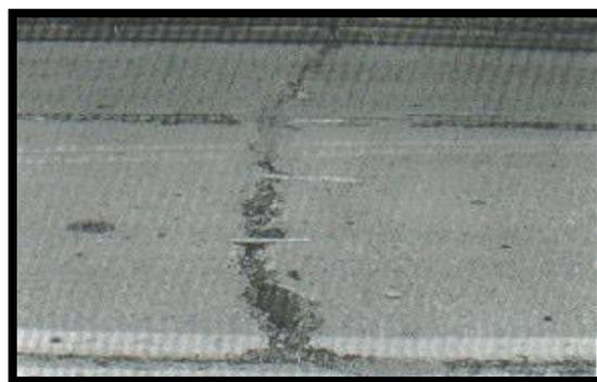
**Figura 27. Grietas lineales de alta severidad en losa de concreto simple.**
