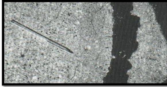
**Figura 13. Grieta de durabilidad de baja severidad.**
