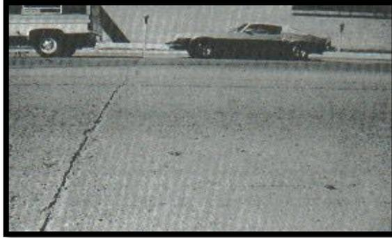
**Figura 50. Descascaramiento de junta de baja severidad.**
