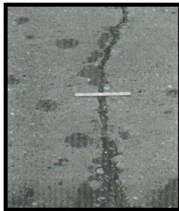
**Figura 26. Grietas lineales de severidad media en losa de concreto reforzado.**
