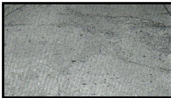
**Figura 15. Grieta de durabilidad de alta severidad.**
