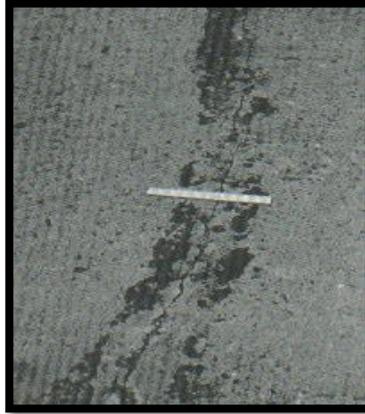
**Figura 25. Grietas lineales de baja severidad en losa de concreto simple.**
