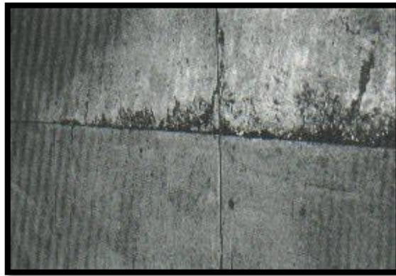
**Figura 51. Descascaramiento de junta de severidad media.**
