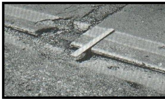
**Figura 22. Desnivel carril / berma de baja severidad.**
