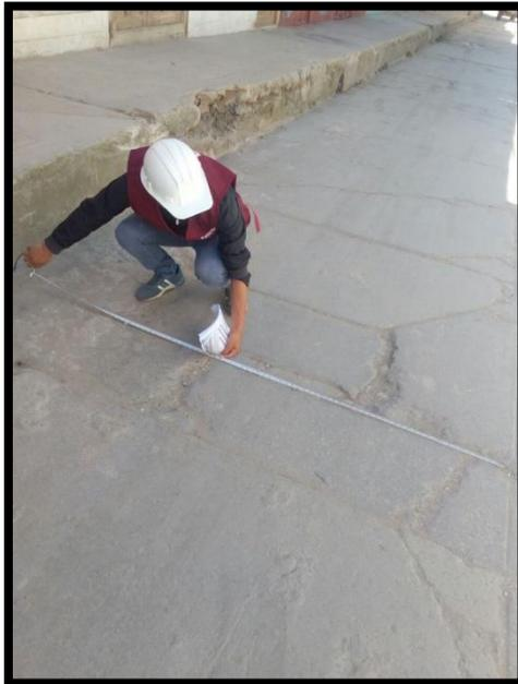
**Figura 84. Falla parcheo grande de severidad alta - presentado en el Jr. Ramón Castilla.**
