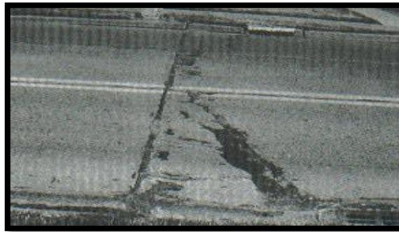
**Figura 38. Punzonamiento de severidad media.**
