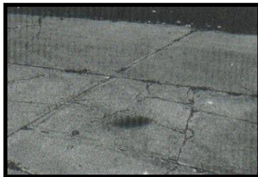
**Figura 12. Losa dividida de alta severidad.**
