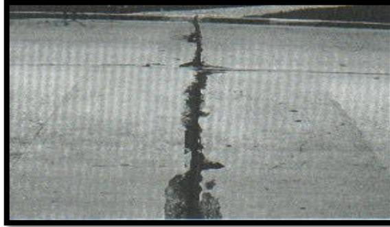
**Figura 19. Daño del sello de junta de baja severidad.**
