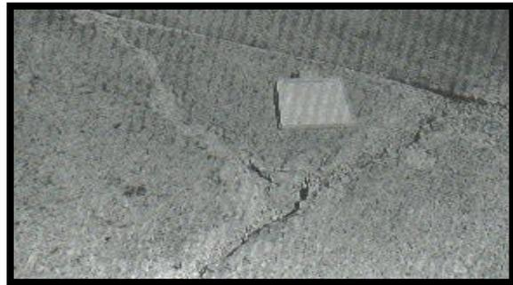
**Figura 9. Grieta de esquina de alta severidad.**
