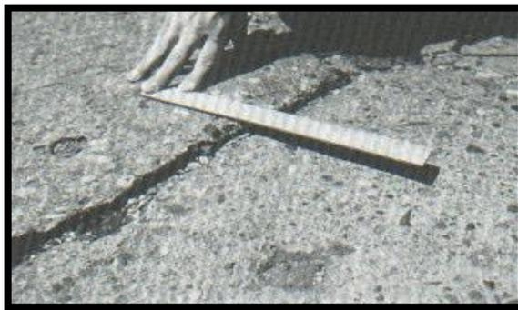
**Figura 17. Escala de severidad media.**
