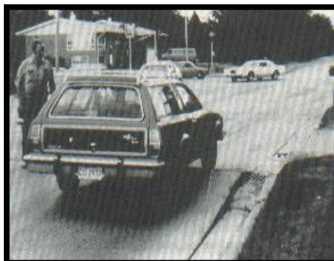
**Figura 6. Blowup / Buckling de alta severidad**
