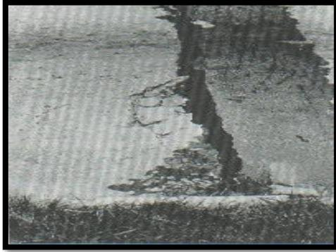
**Figura 4. Blowup / Buckling de baja severidad.**
