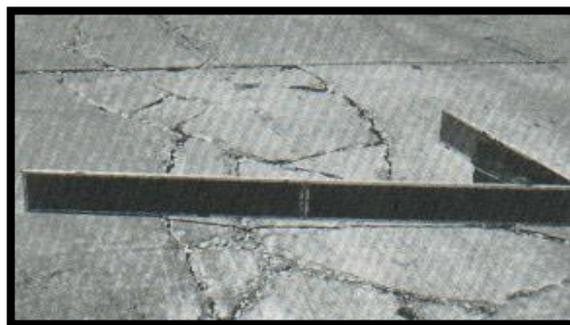
**Figura 39. Punzonamiento de alta severidad.**
