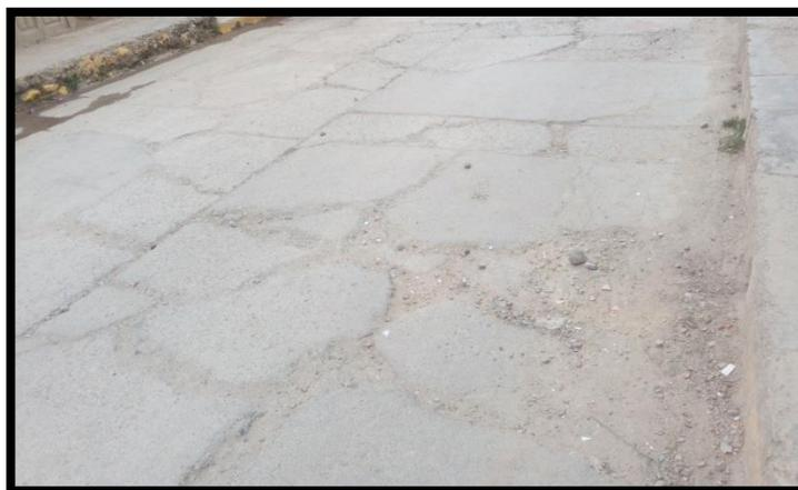
**Figura 76. Falla Punzonamiento de severidad alta - presentado en el Jr. Ramón Castilla.**
