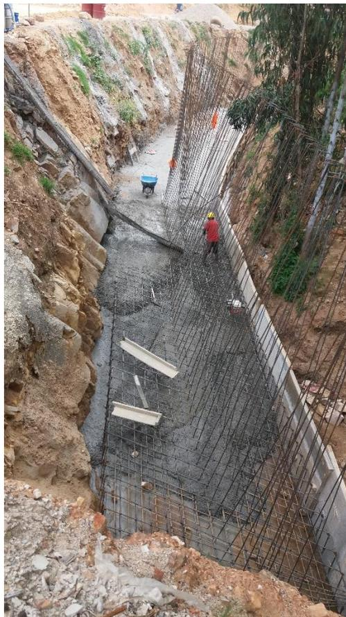
Llenado de zapata de espesor de 0.80m y un ancho de 3.90m
