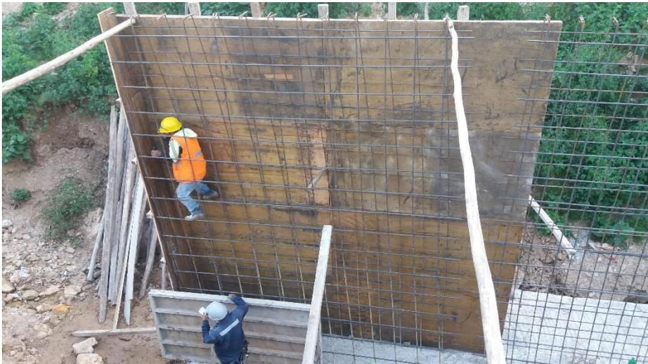
Encofrado de pantalla de muro en voladizo con paneles
