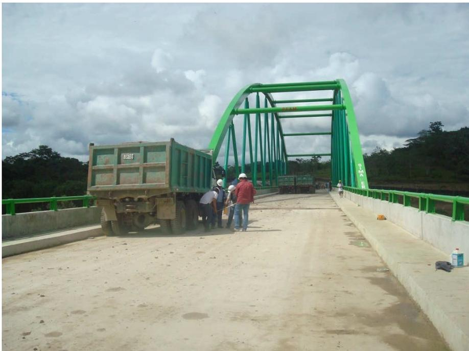
Fig. N° 75 Medición de los puntos cuando los vehículos se encuentran al borde de la vereda aguas abajo, la carga vehicular se encuentra en paralelo.
