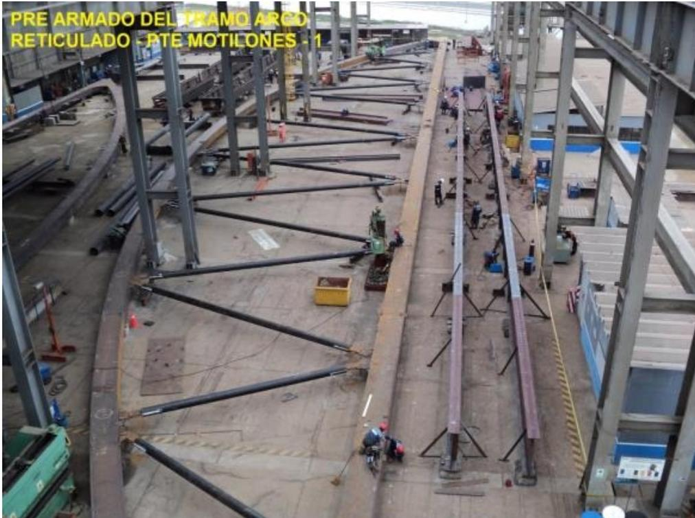
Fig. N° 72 Fabricación y pre armado del arco lado mostrado puente Motilones
