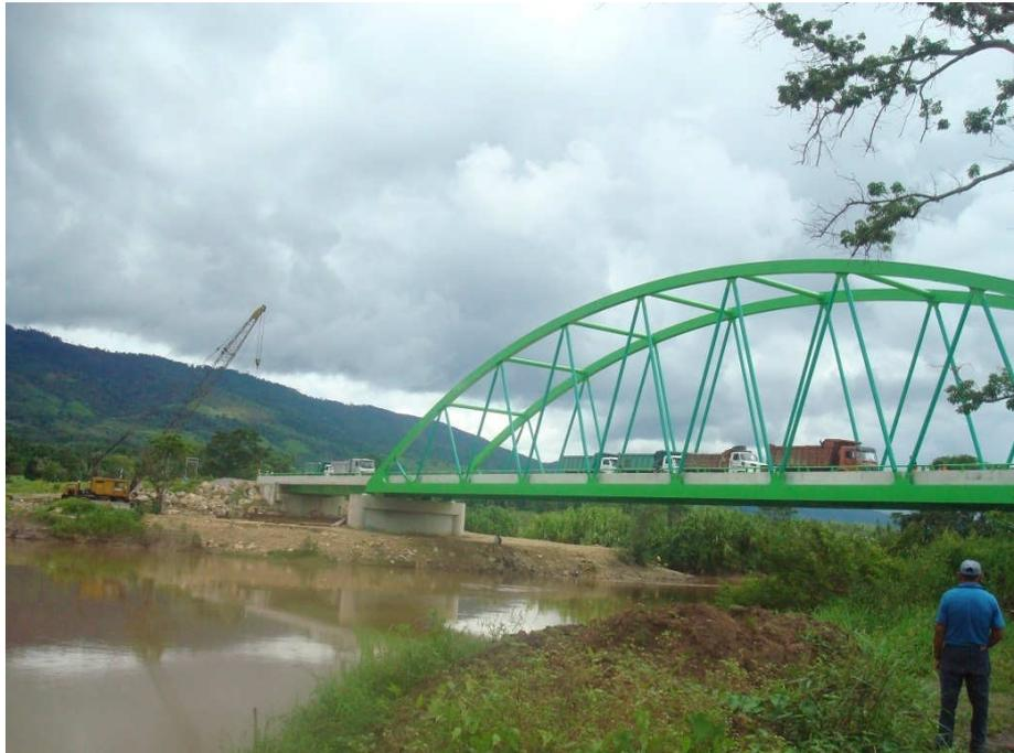
Fig. N° 80 Vista panorámica del puente cargado en forma lineal.
