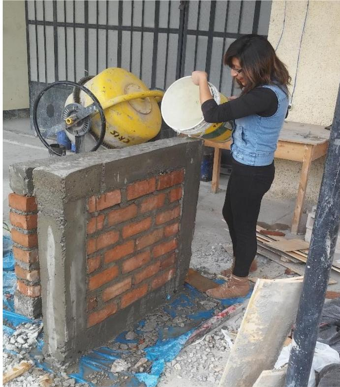
**Figura 46.** Curado de muros confinados
