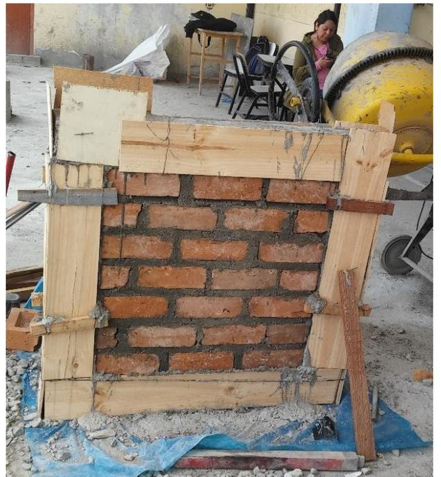
**Figura 45.** Construcción de muros confinados
