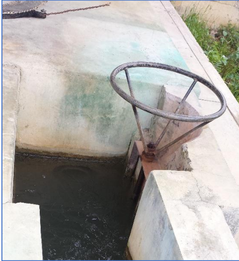
Figura 9: Cámara de entrada
