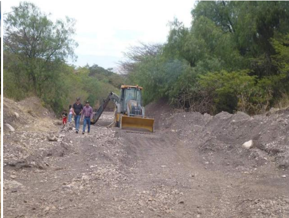
Fotografías 16 y 17. Des colmatación de río Cajamarquino (Coordenadas UTM 809761 m este y 9177183 m norte) y quebradas Colina (Coordenadas UTM 818306 m este y 9174640 m norte).
