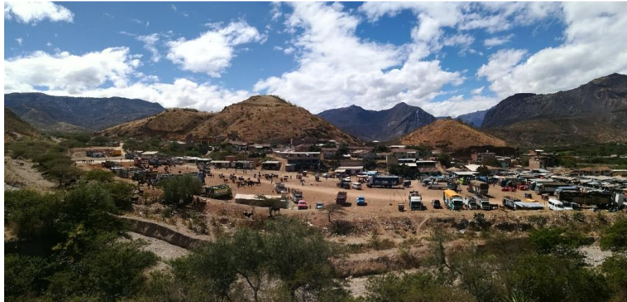
Fotografía 2: Área comercial Centro Poblado Aguas Calientes (Coordenadas UTM 818054 este y 9174125 norte)
