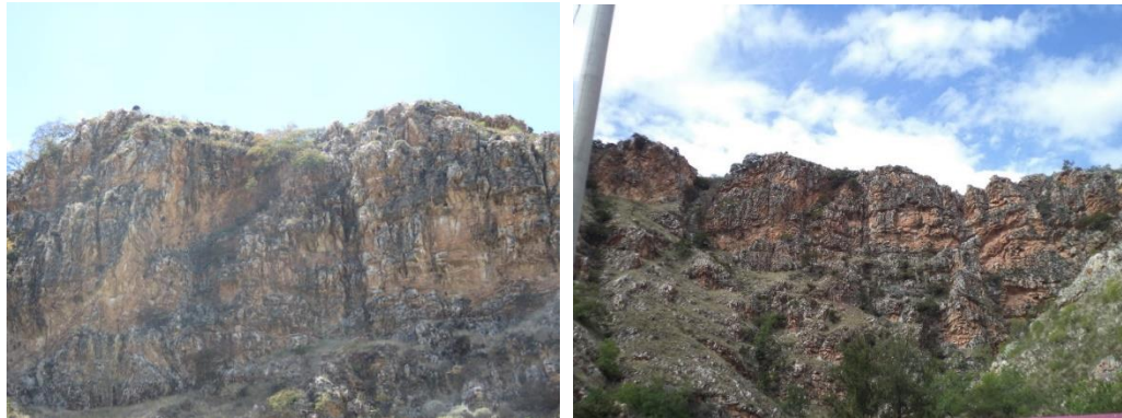
Fotografía 8: Categoría Afloramiento Rocoso comunidad Colpon (Coordenadas UTM 807986 este y 9180284 norte).
