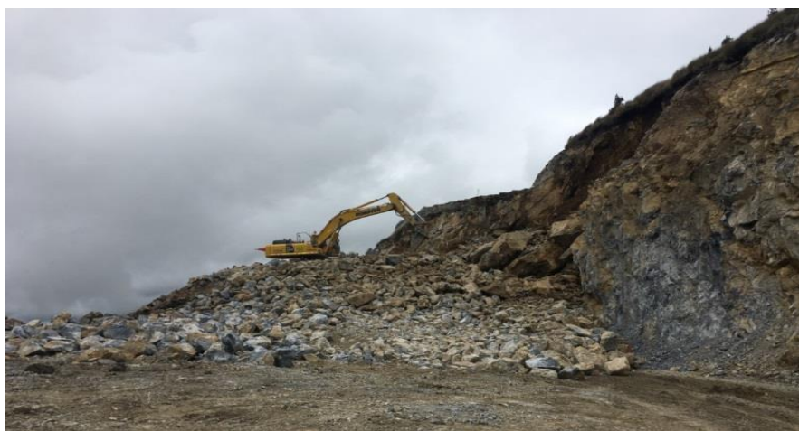
Figura N° 13: Fracturamiento de bolonería realizado por el picotón en el nivel 3800
