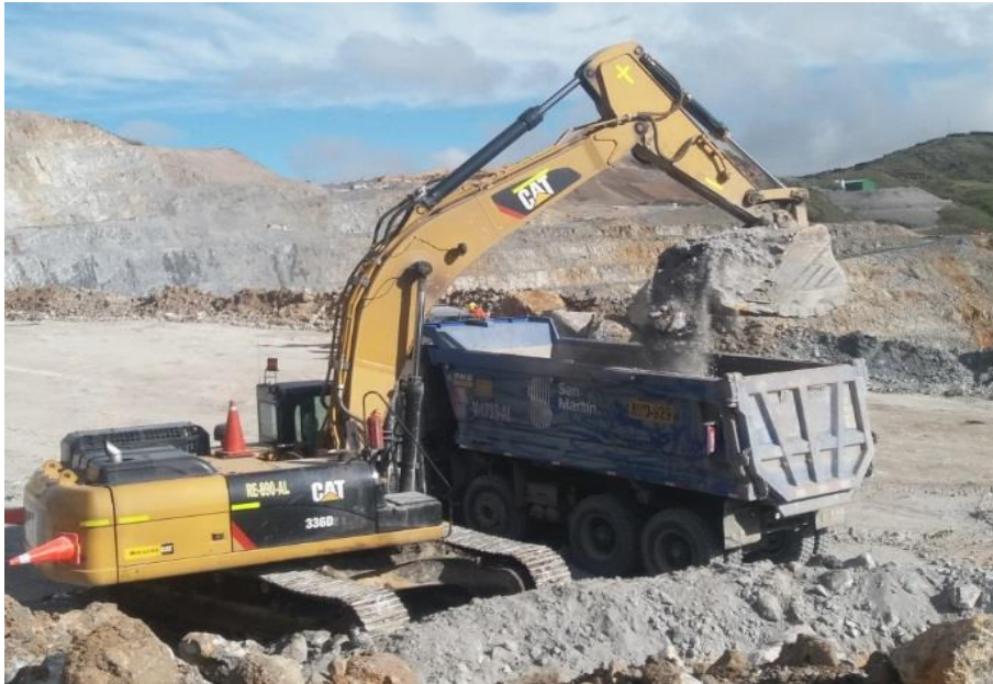
Figura N° 8: Excavadora CAT336 realizando carguío en el nivel 3790
