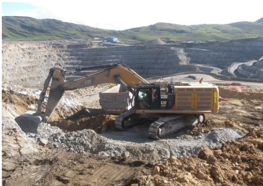
Figura N° 7: Excavadora CAT374 realizando carguío en el nivel 3800
