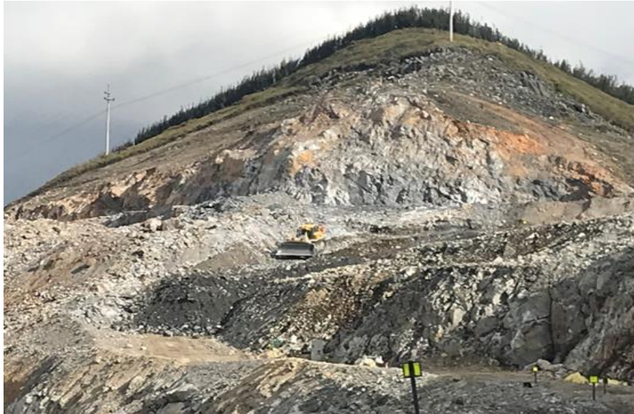
Figura N° 9: Tractor en construcción de rampa 3800 - Cerro Perú
