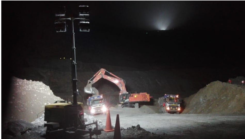
Figura N° 17: Iluminación al frente de carguío en el nivel 3790
