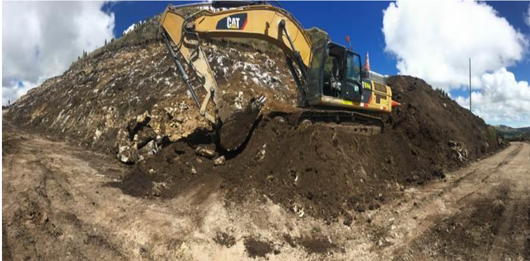
Figura N° 16: Stripping de top soil realizado por una excavadora CAT336 en Cerro Candela
