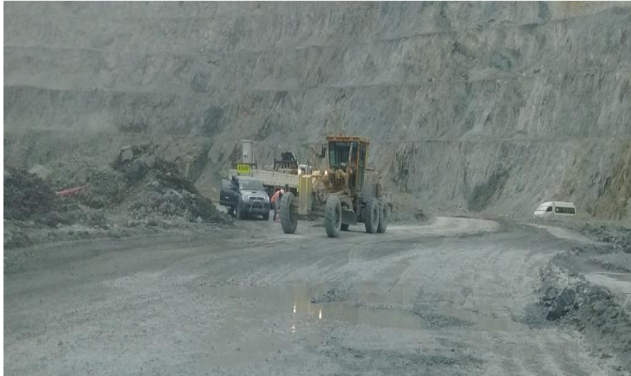
Figura N° 10: Motoniveladora en lastrado de la rampa principal
