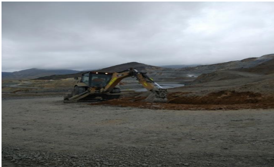
Figura N° 11: Limpieza de cunetas realizado por la retroexcavadora en 5 esquinas
