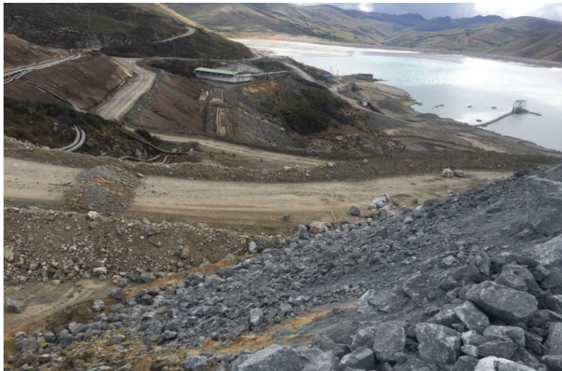
Figura N° 12: Muro colocado para cerrar el acceso al botadero Maricruz
